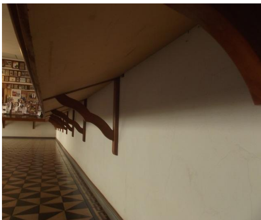
FIGURA 71 – Detalhe da sustentação das vitrines / estrutura.
