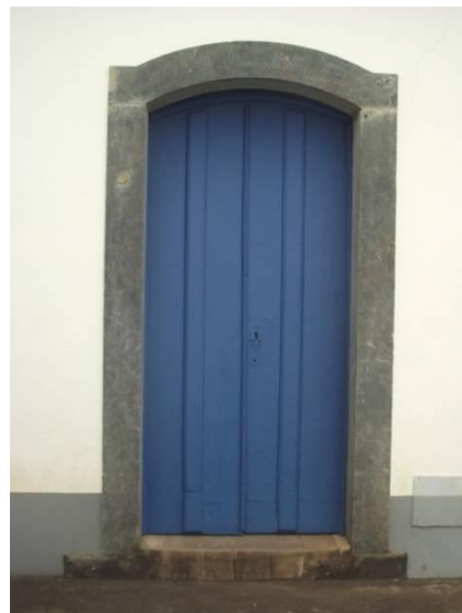
FIGURA 67 – Porta em duas folhas com técnica “meio fio”. Foto: Thiago Botelho, 2012.
