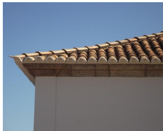
FIGURA 65 – Detalhe dos beirais. Foto: Thiago Botelho, 2012.
