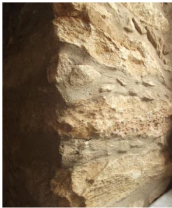
FIGURA 62 – Detalhe do sistema construtivo/ alvenaria Foto: Thiago Botelho, 2012
