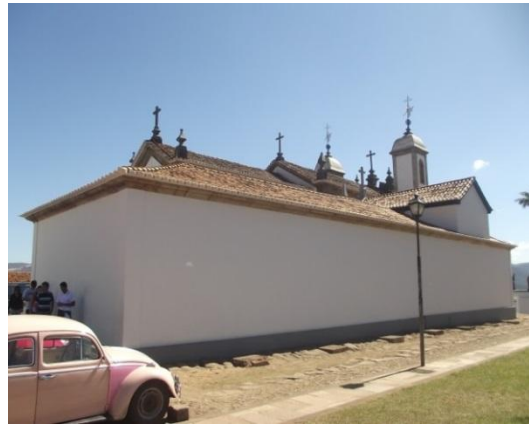
FIGURA 63 – Vista parcial da cobertura/ sistema construtivo Foto: Thiago Botelho, 2012.
