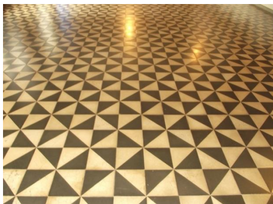
FIGURA 68 – Detalhe do piso hidráulico Foto: Thiago Botelho, 2012.
