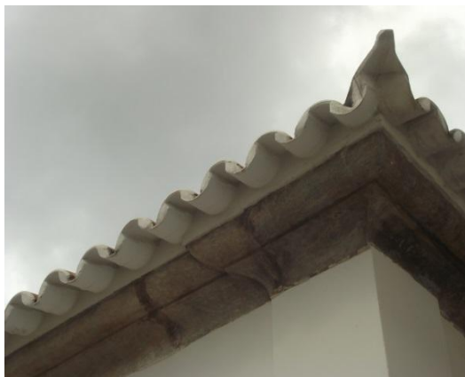
FIGURA 64 – Detalhe dos beirais. Foto: Thiago Botelho, 2012.
