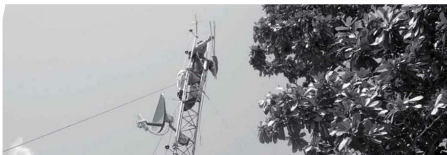
Figura 17 – Instalação de uma das antenas.
