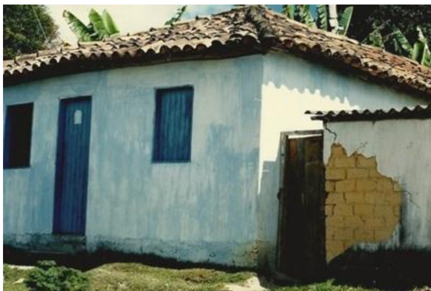
Figura 59 - Casa de Adobe [entre 1994 e 2014]. Fotografia de Joice Saturnino. Fonte: Arquivo pessoal da Autora.
