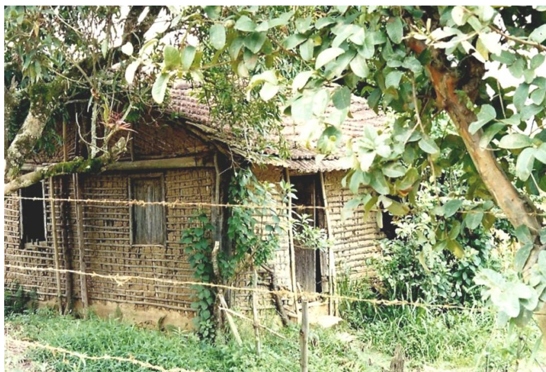
Figura 65 - pau-a-pique com varas próximas. [entre 1994 e 2014]. Fotografia de Joice Saturnino. Fonte: Arquivo pessoal da Autora.
