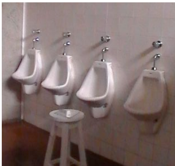
Figura 28 – Espelho sobre banco e mictórios do banheiro masculino da área externa do CCUFMG.
