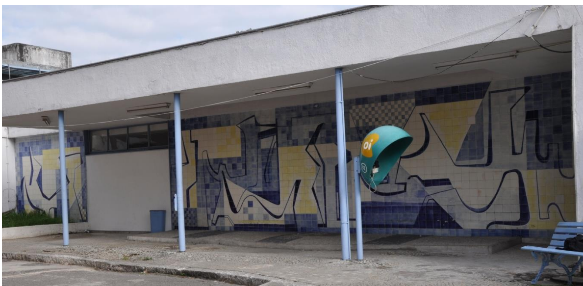
FIGURA 14: Revestimento cerâmico assinado por Burle Marx, no IPPMG, na Universidade Federal do Rio de Janeiro. Fonte: Arquivo pessoal. Obtido em março/2015.
