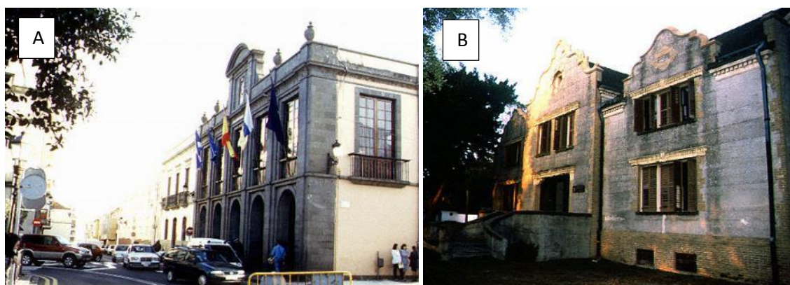
Figura 13 – A) Fachada do Arquivo Histórico em San Cristóbal na Espanha e B) Edifício Hollybourne Cottage nos USA onde foram implantados os primeiros sistemas de climatização alternativos. Fotos: Shin Maekawa (1997-2002).
