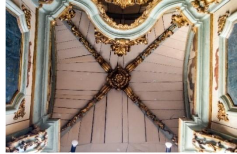
FIGURA 102 - Forro Passo do Carmo, São João del Rei/MG
