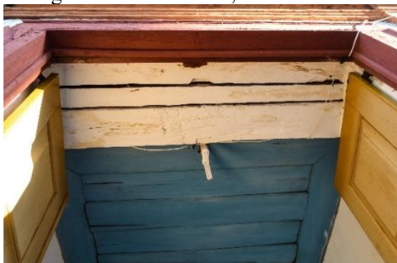
FIGURA 192 - Forro Passo Largo das Forras e “gambiaras” elétricas, Tiradentes/MG
