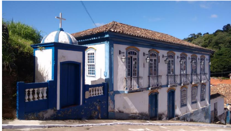
FIGURA 12 - Passo de Rua no núcleo histórico, vista em perspectiva para fachada, Prados/MG
