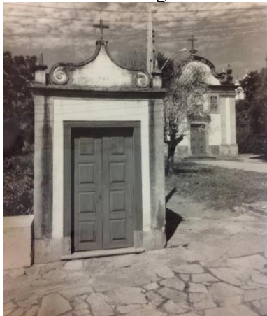
FIGURA 140 - Registro fotográfico em 1950 do Passo Largo do Rosário
