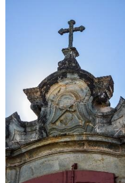
FIGURA 60 - Coroamento Largo do Rosário, São João del Rei/MG
