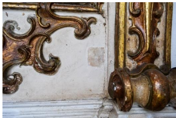
FIGURA 201 - Intervenções de repintura com uso de purpurina no douramento - Passo das Mercês, São João del Rei/MG
