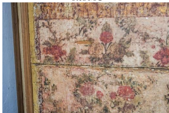
FIGURA 207 - Repintura e desgaste da policromia - Passo Rua da Prata, São João del Rei/MG
