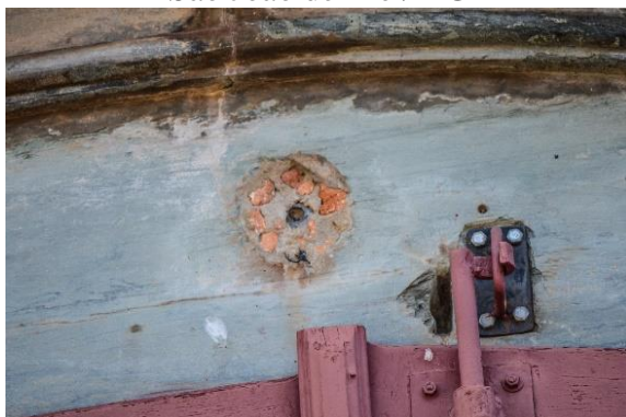
FIGURA 162 - Substituição do elemento de serralheria da porta - Passo Largo da Cruz, São João del Rei/MG
