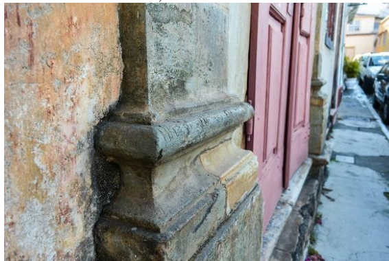
FIGURA 171 - Enxerto na cantaria - Passo Largo do Rosário, São João del Rei/MG
