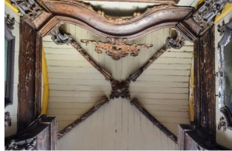
FIGURA 108 - Forro Passo Largo do Rosário, São João del Rei/MG
