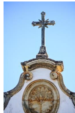
FIGURA 58 - Coroamento Passo Rua da Prata. São João del Rei/MG
