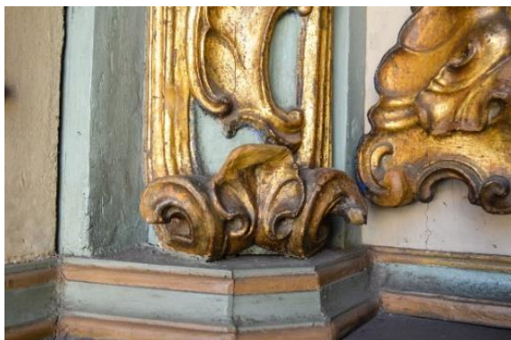
FIGURA 200 - Intervenções no douramento com aplicação de massas - Passo do Carmo, São João del Rei/MG
