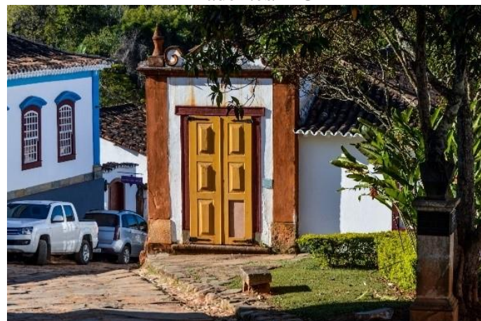
FIGURA 6 - Passo de Rua no Largo Pelourinho, vista externa para a fachada externa, Tiradentes/MG
