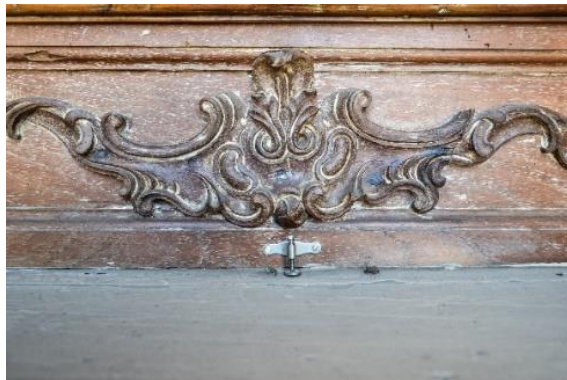
FIGURA 199 - Perda total da policromia e do douramento no Passo do Largo do Rosário, São João del Rei/MG
