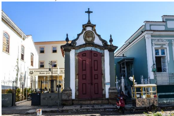
FIGURA 57 - Vista frontal Passo Rua da Prata, São João del Rei/MG
