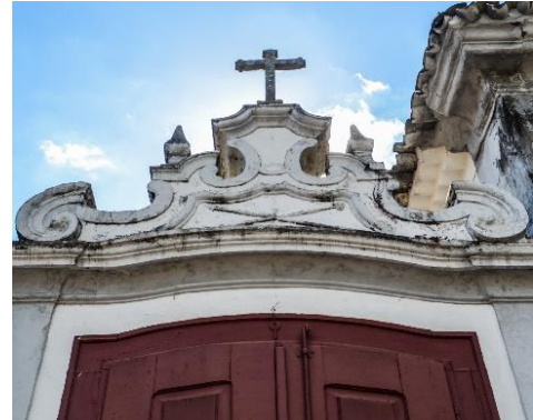
FIGURA 66 - Coroamento Passo das Mercês, São João del Rei/MG
