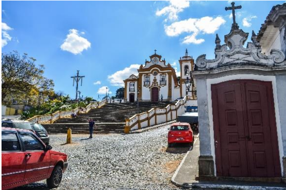
FIGURA 65 - Vista frontal Passo das Mercês. São João del Rei/MG
