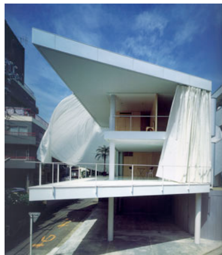
Figura 17 Curtain House, 1995. Arquiteto: Shigeru Ban http://www.designboom.com/history/ban_curtainwall.html , acessado em 28/02/2012.
