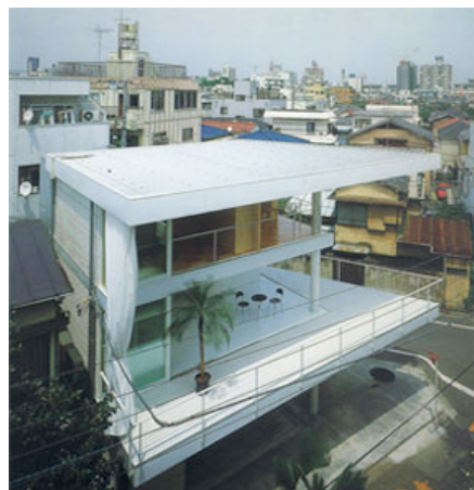
Figura 18 Curtain House, 1995. Arquiteto: Shigeru Ban http://www.designboom.com/history/ban_curtainwall.html , acessado em 28/02/2012.
