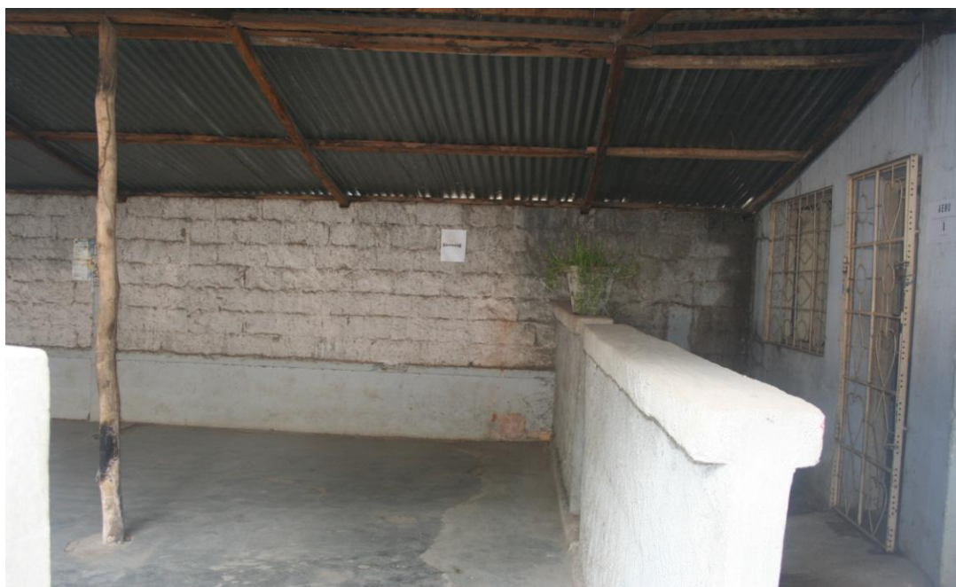
Figura 1: Antigo edifício da BPPN – balcão de atendimento e depósito.
