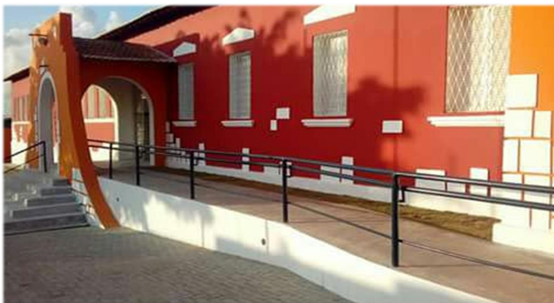
Figura 12 - Fachada da Escola Estadual Raul Machado, Ilha do Bispo, João Pessoa-PB
