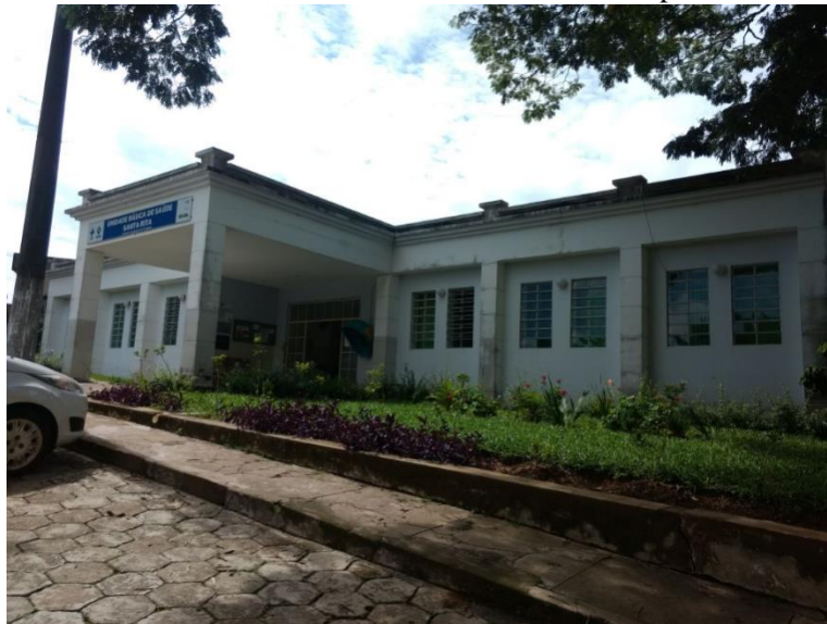
Figura 4 – UBS Santa Rita, situada no bairro Centro, Ritópolis/MG, 2018.
