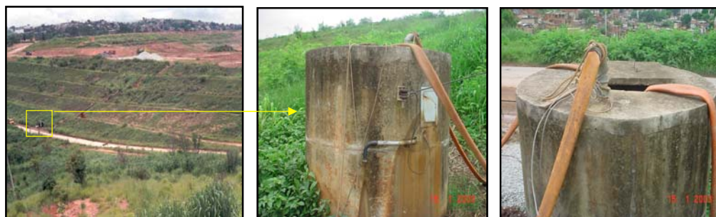
FIGURA 4.2: Visão geral da célula emergencial e do piezômetro de coleta do líquido lixiviado PLQ-6A
