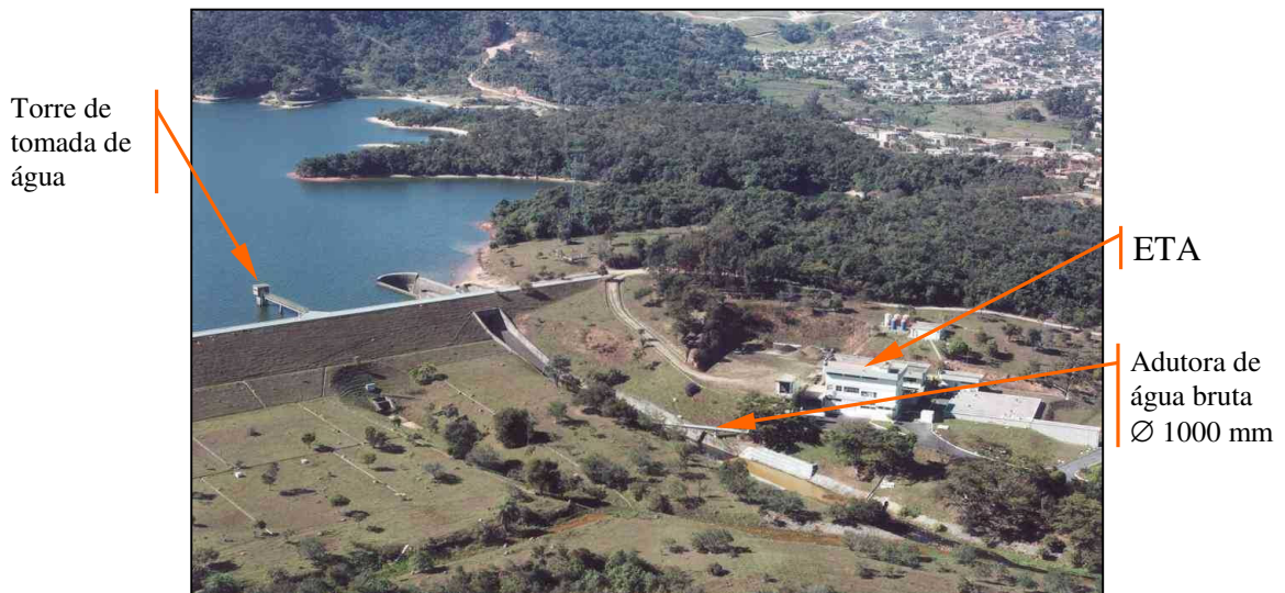
Figura 4.1 – Foto aérea parcial da Represa e da ETA de Vargem das Flores.
