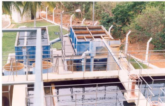
**Figura 4.7** - Em primeiro plano aparece a ETA de concreto, com capacidade de 8 l/s e ETA metálica para 12 l/s, Mato Verde
