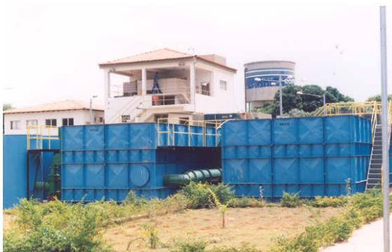
**Figura 4.4** - vista das ETAs pré fabricadas de Januária (02 unidades), com capacidade total para 100 l/s. Ao fundo casa de química.
