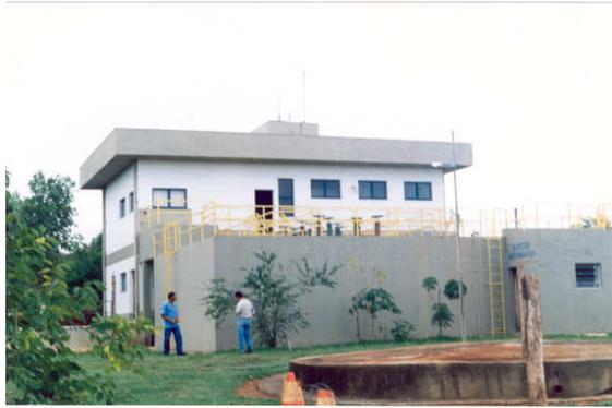
**Figura 4.8** - ETA de Três Marias, com capacidade para 100 l/s, constituída de clarificadores de contato. Ao fundo Casa de Química.
