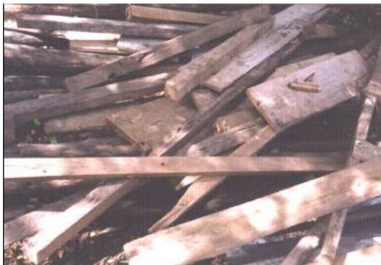
Figura 3.2 – Resíduos de construção civil
