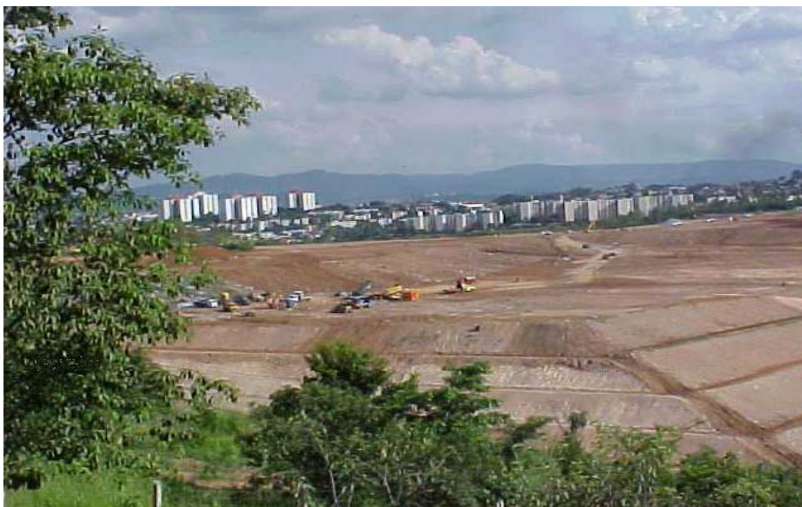
Figura 5 - Vista parcial do maciço do aterro sanitário de Belo Horizonte (novembro de 2004).
