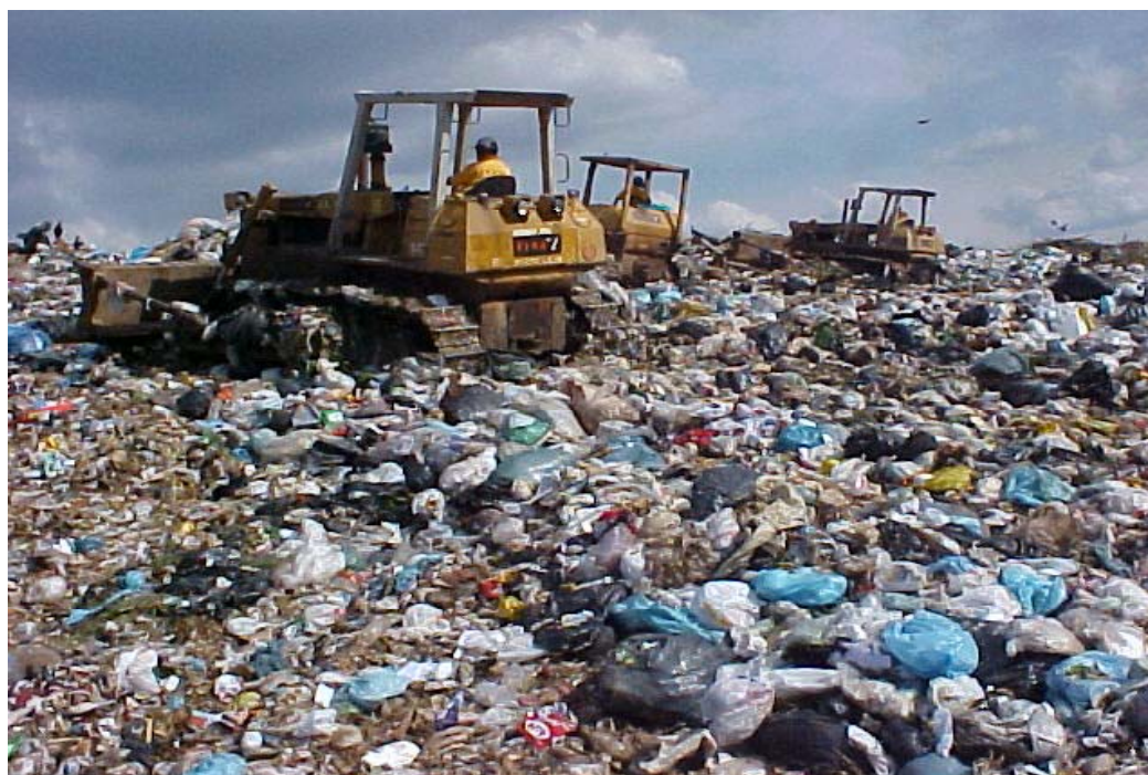
Figura 10 – Compactação dos RSS codispostos, com tratores de esteira.
