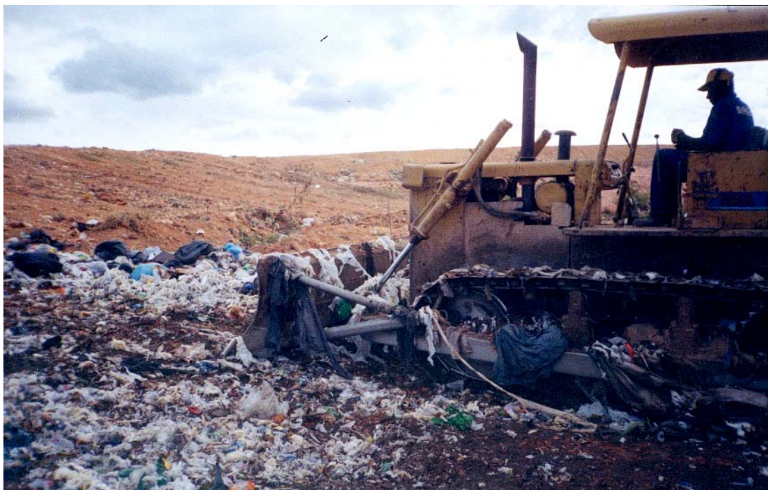
Figura 14 – Operação do trator na operação de codisposição – Betim (outubro de 2004).
