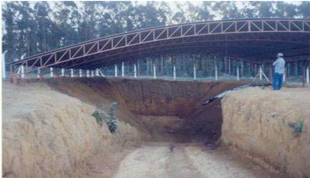
Figura 16 – A vala séptica é coberta por uma estrutura metálica móvel (agosto/2004).
