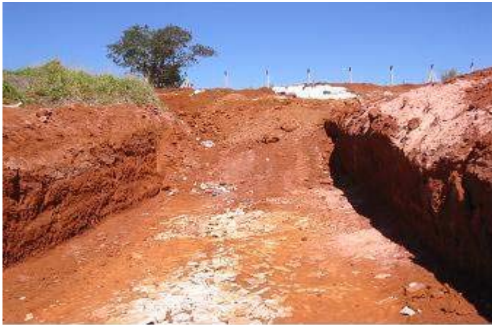
Figuras 19 – Aterro sanitário de Três Corações – vala séptica com disposição incorreta de RSS (maio/2004).
