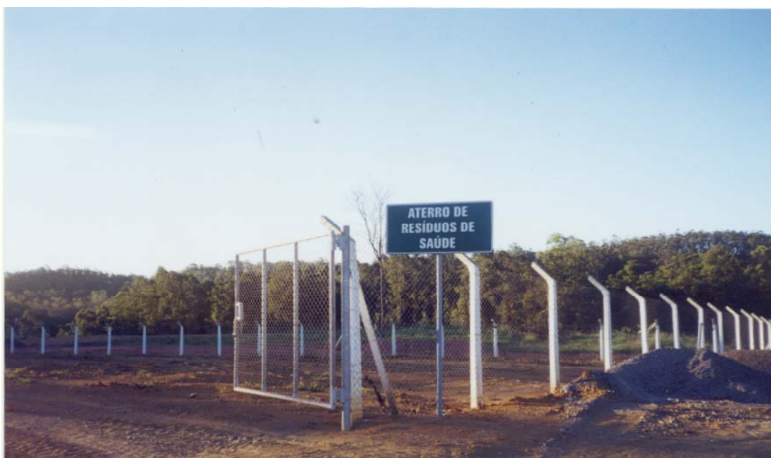
Figura 15 – Vista parcial do aterro de resíduos de saúde de Ipatinga (agosto/2004).
