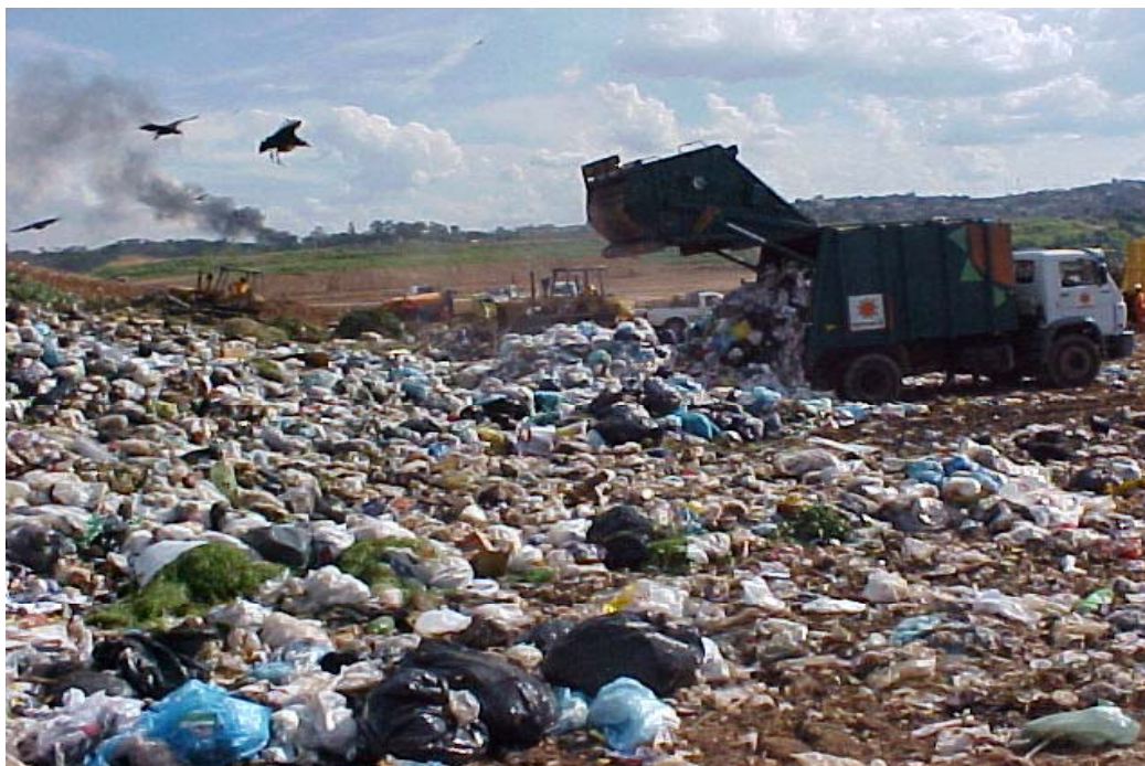
Figura 9 – Operação de descarregamento dos RSU por caminhão compactador (11/ 2004).
