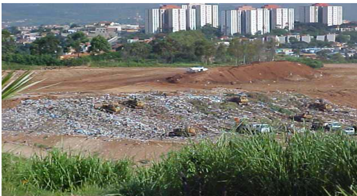
Figura 7- Vista da frente de serviço (novembro, 2004).
