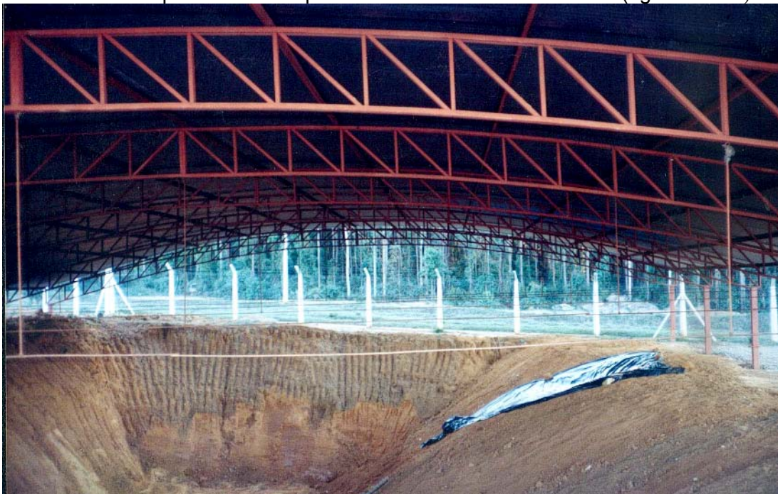
Figura 16 – A vala séptica é coberta por uma estrutura metálica móvel (agosto/2004).
