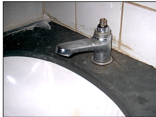
Figura 5.13 – Torneira intacta e sem o botão de acionamento
