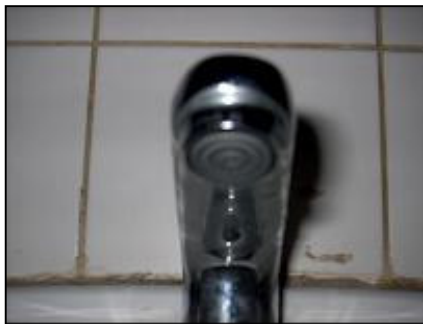
Figura 5.14 – Torneira intacta e sem arejador
