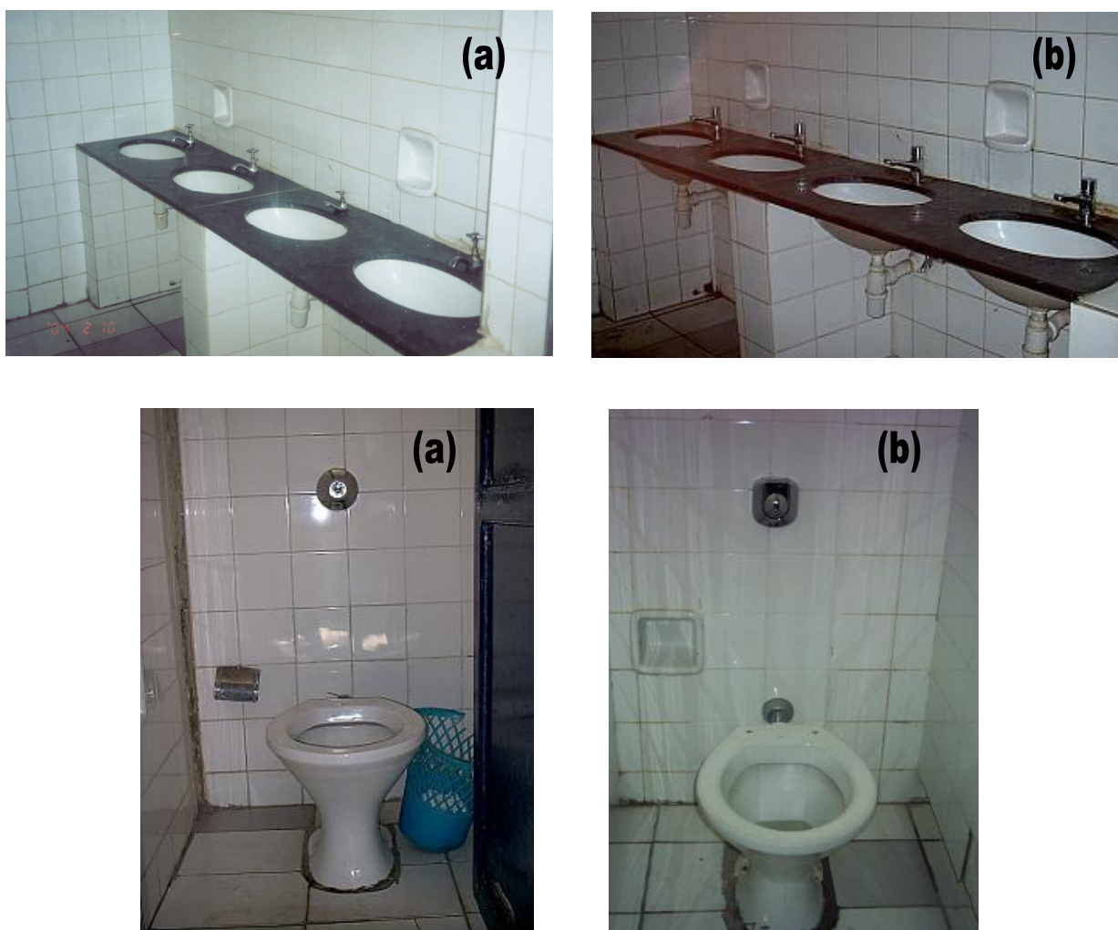
Figura 4.12 – Instalações sanitárias de uso dos alunos antes (a) e após (b) a troca dos equipamentos
