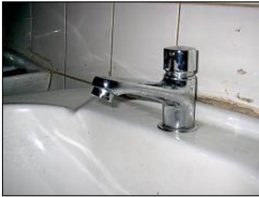
Figura 5.13 – Torneira intacta e sem o botão de acionamento
