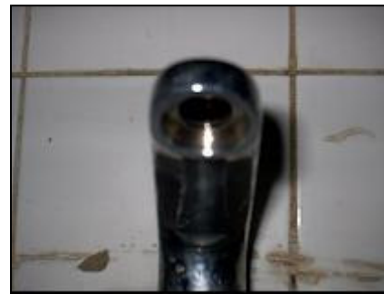
Figura 5.14 – Torneira intacta e sem arejador
