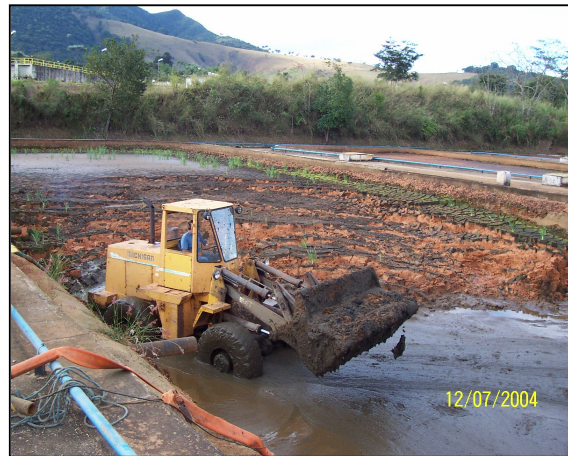
Figura 4.9 – Retirada de resíduo da lagoa de lodo para disposição em aterro controlado
