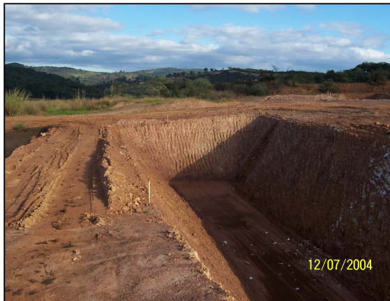
Figura 4.10 – Vista geral do aterro controlado
