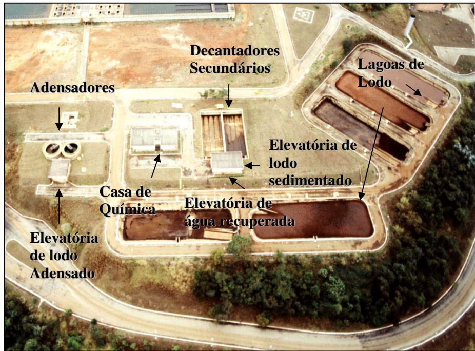
Figura 4.4 – Vista aérea da UTR – Rio Manso
