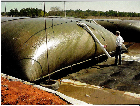
Figura 3.2 – Acondicionamento do lodo no “ geotube ”. Fonte: Miratech
