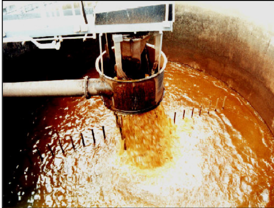
Figura 4.6 - Adensador da UTR recebendo lodos provenientes dos decantadores da ETA
