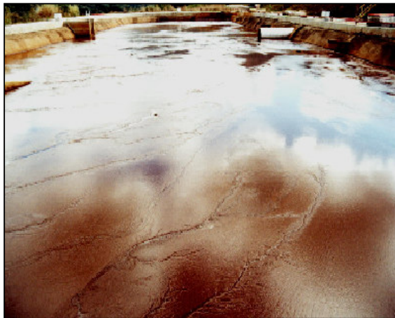
Figura 4.8 - Lagoas de lodo recebendo lodo adensado.
