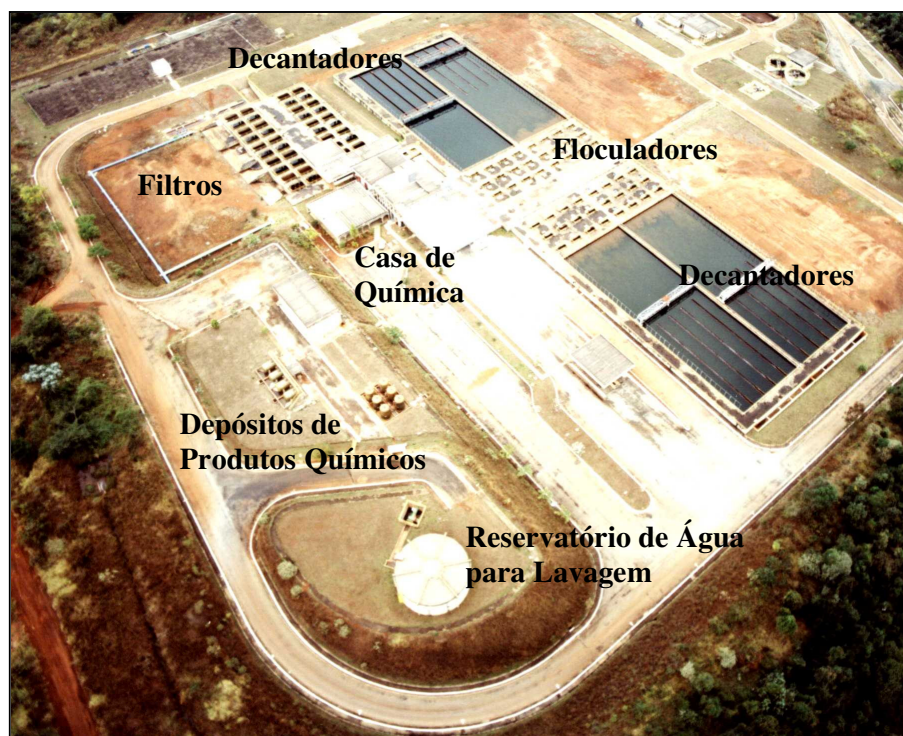
Figura 4.2 - Vista aérea da ETA Rio Manso – Brumadinho
