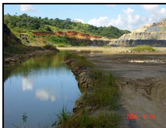
Foto 60 - Canal de fundo para o sump - frente de lavra Norte.
