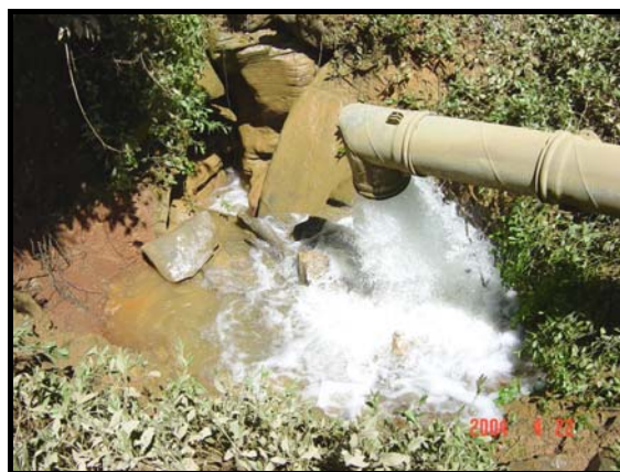
Foto 04 - Descarga de injeção – 360m 3 /h.
