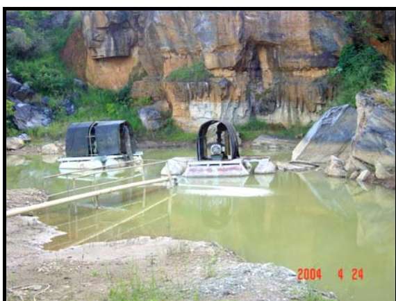
Foto 59 - Estação de bombeamento - sump de lavra Norte.
