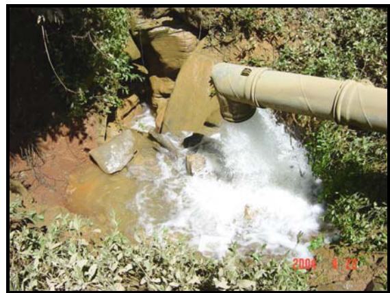
Foto 04 - Descarga de injeção – 360m 3 /h.
