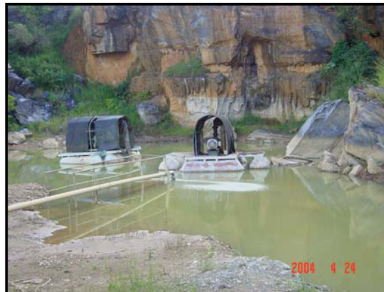
Foto 54 - Estação de bombeamento, sump .
