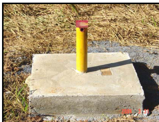
Foto 56 - Poço piezométrico simples.
