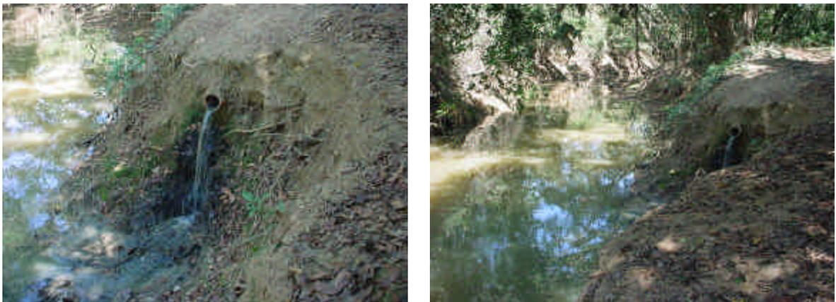
Figura 5.21 – Ponto de lançamento de esgoto *in natura* Abaeté-5.
