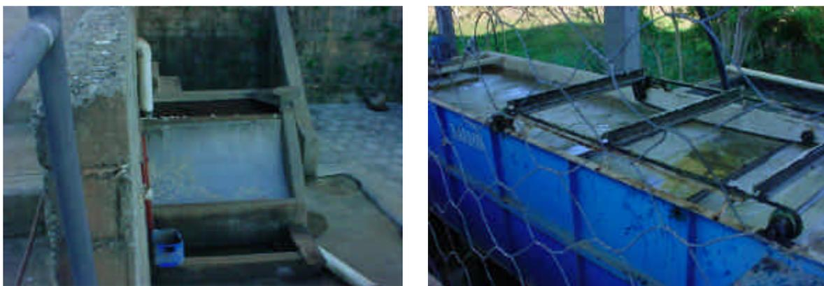
Figura 5.8 – Filtro e decantador da estação de tratamento de efluentes do Empreendimento 2.
