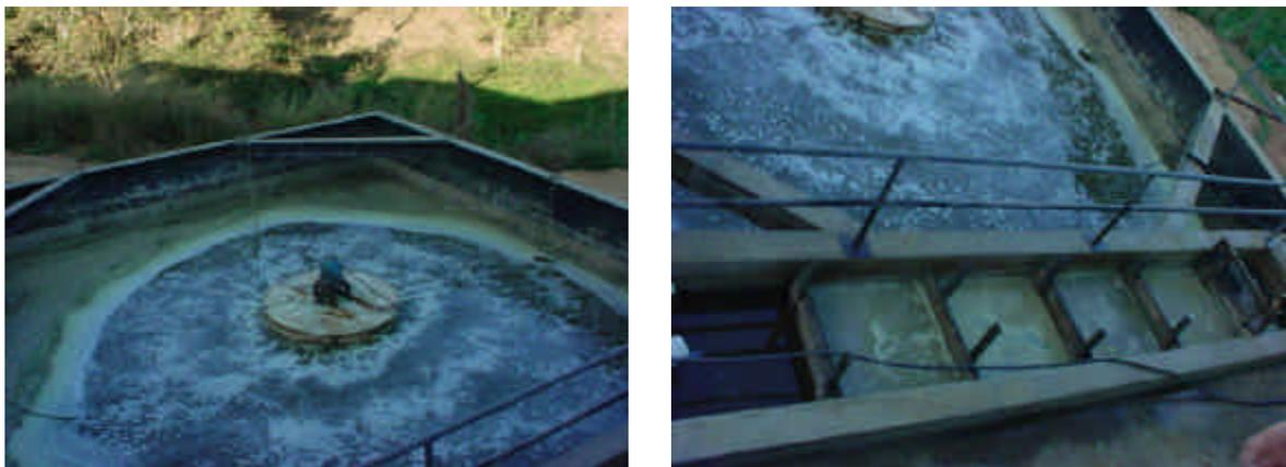
Figura 5.7 – Tanque de aeração e filtro da estação de tratamento de efluentes do Empreendimento 2.
