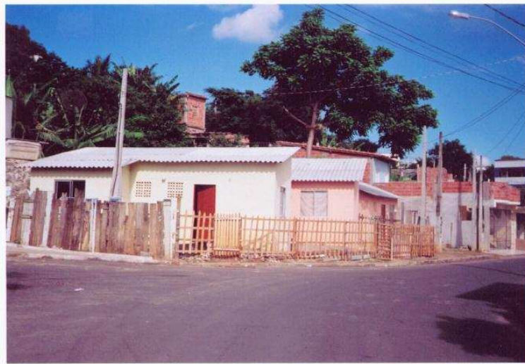
FIGURA 3.6 – Imagem de casas em Mangue Seco construídas pelo Projeto Terra - PMV
