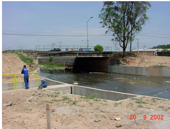
FIGURA 4.4: Bacia de distribuição e controle de vazões.
