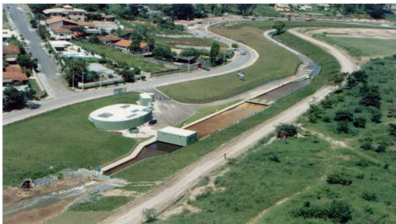
FIGURA 4.2: Vista geral da ETAF-Pampulha (Foto:Sudcap)
