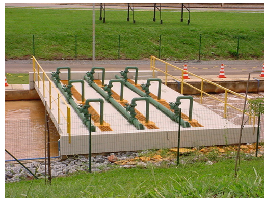
FIGURA 4.11: Sistema de injeção de ar dissolvido.
