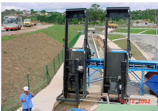
FIGURA 4.5: Grades finas de limpeza mecanizada.
