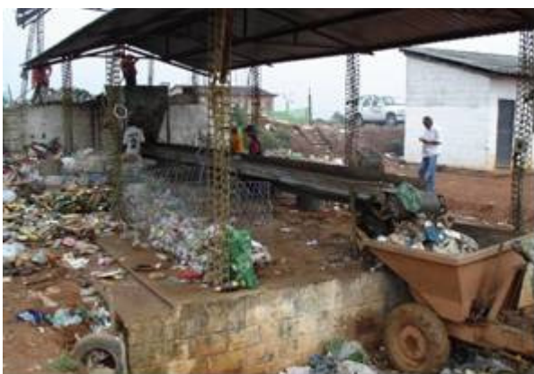
Figura 34 – Vista parcial da UTC. Detalhe para a esteira de triagem e as instalações gerais (até setembro de 2006).
