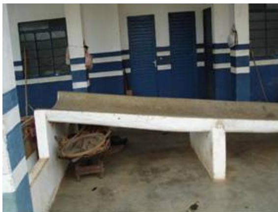
Figura 22 – Vista parcial da UTC de Francisco Badaró. Detalhe para a rampa de triagem de RSU e as instalações gerais.
