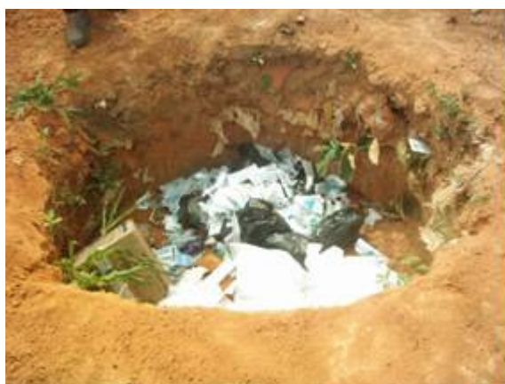
Figura 20 – Momento de disposição final dos RSSS em vala no “lixão” de Francisco Badaró (julho de 2006).
