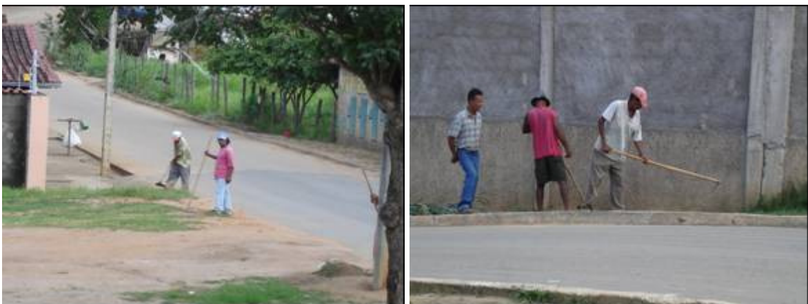
Figura 33 – Vista geral da Capina em calçadas e passeios. Não se observa a utilização adequada de Equipamento de Proteção Individual.
