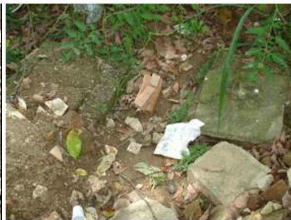
Figura 42 – Vista geral da Fossa Séptica.
