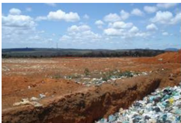
Figura 36 – Vista geral dos RS, com detalhe para o esgotamento das trincheiras para disposição (outubro de 2006).
