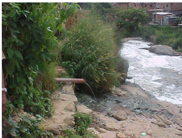
Figura 40 – Ponto de lançamento de esgoto no Ribeirão da Onça.
