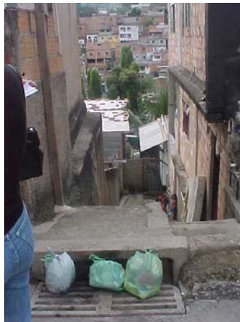
Figura 45 – Acúmulo de lixo na boca-de-lobo.
