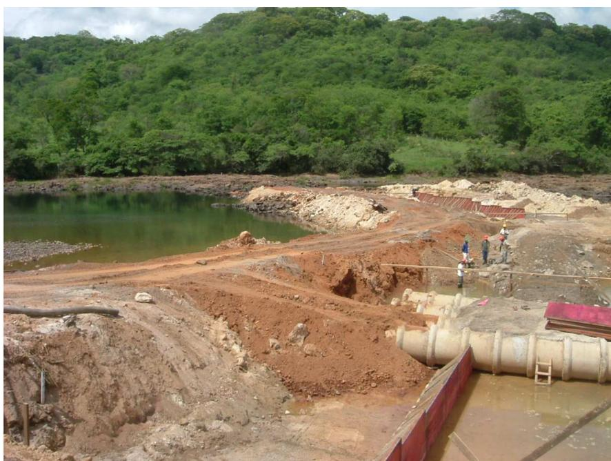
**Figura 4.1** – Instalação da quarta soleira vertente no trecho de vazão reduzida da UHE Capim Branco I.
