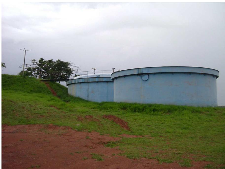
**Figura 4.5** – Reator UASB seguido por filtro anaeróbio – ETE Ipanema, Uberlândia/MG.
