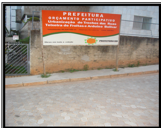
Figura 3.29 - Pavimentação de rua
