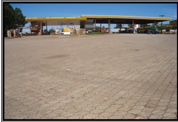
Figura 3.35 - Pátio de posto de gasolina na BR 040
