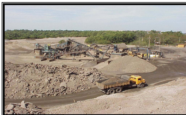
Figura 3.11 - Planta de beneficiamento da escória Fonte: CST, 2006.
