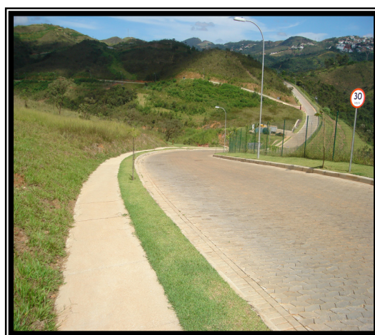
Figura 3.32 - Rua interna do condomínio
