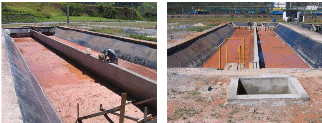
Figura 4.7: Unidades de wetlands em construção com destaque para o muro de alvenaria impermeabilizado o fundo de argila compactada e a geomembrana cobrindo os taludes.
