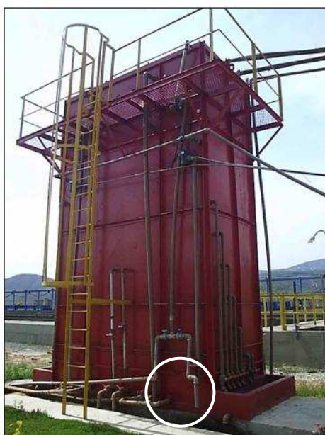
Figura 4.2: Reator UASB com destaque para o ponto de amostragem e medição de vazão
