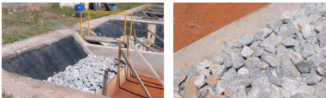
Figura 4.8 – Processo construtivo do leito de pedra de mão destacando sua granulometria.
