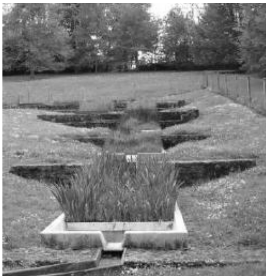
FIGURA 3.2 – Wetland vertical de fluxo subsuperficial
