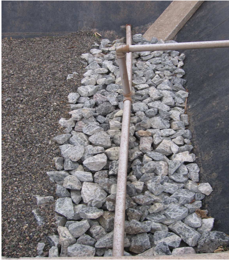
Figura 4.9 : Tubulação de distribuição do afluente nas unidades de wetlands com destaque para os furos ao longo de seu comprimento.
