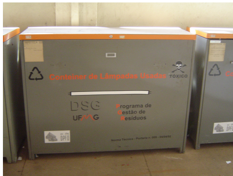
FIGURA 44 – Contenedores para lâmpadas fluorescentes (31/10/2007).
