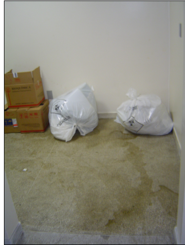
FIGURA 52 – Líquido no chão, 2º andar (11/7/2006).
