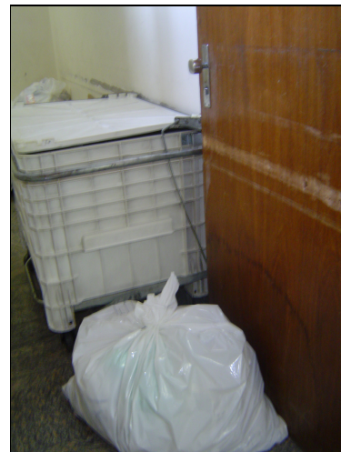
FIGURA 54 – Saco encostado na porta impedindo o fechamento. Pronto Atendimento (PA), 1º andar (11/7/2006).
