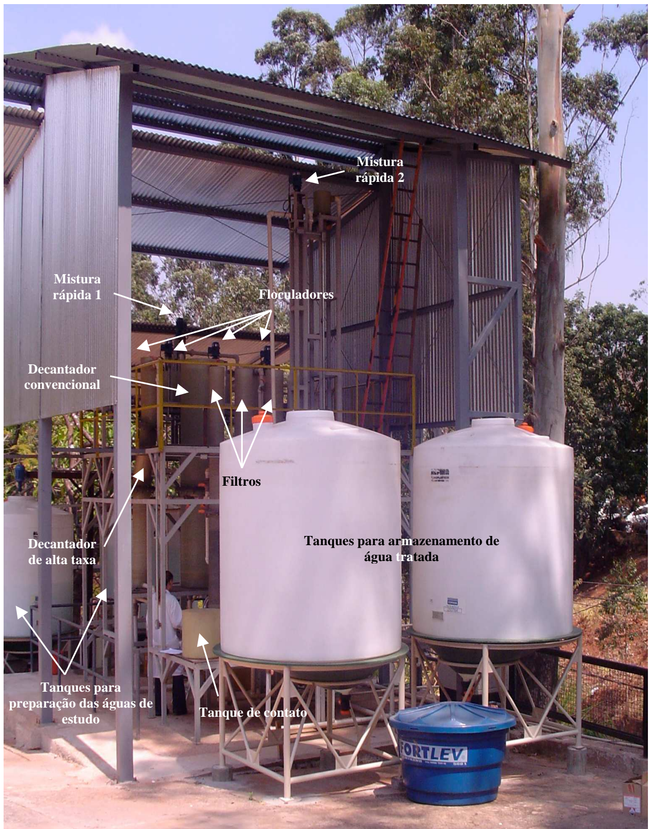
Figura 4.3: Vista geral da ETA Piloto.
