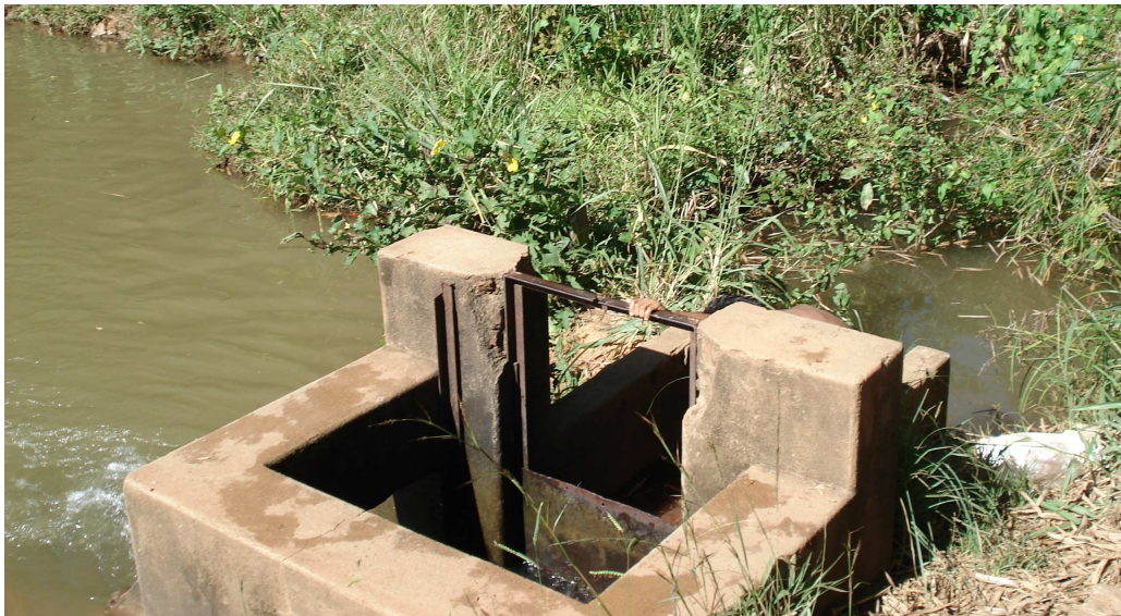
Figura 6-7 – Vertedor da lagoa da Baiana, no início do canal de irrigação.
