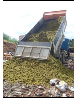
Figura 4.30: Descarregamento de conteúdo ruminal no aterro
