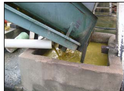
Figura 4.12: Tubulação para o líquido extraído
