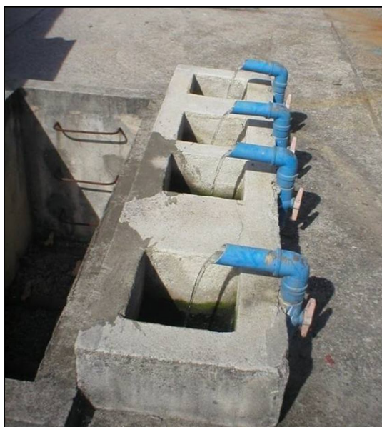
Figura 4.6 – Ponto de medição de vazão efluente do reator UASB
