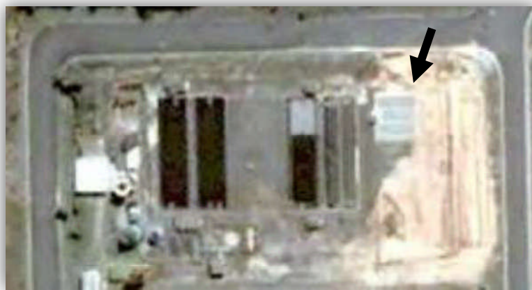
Figura 4.12 – CePTS, destacada a escala piloto dos leitos de fluxo vertical
