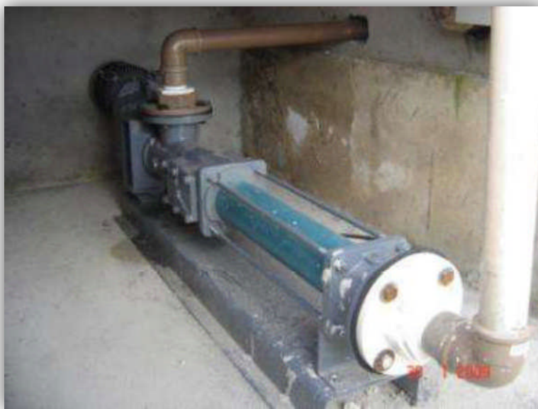
Figura 4.9 – Bomba do tipo Nemo
