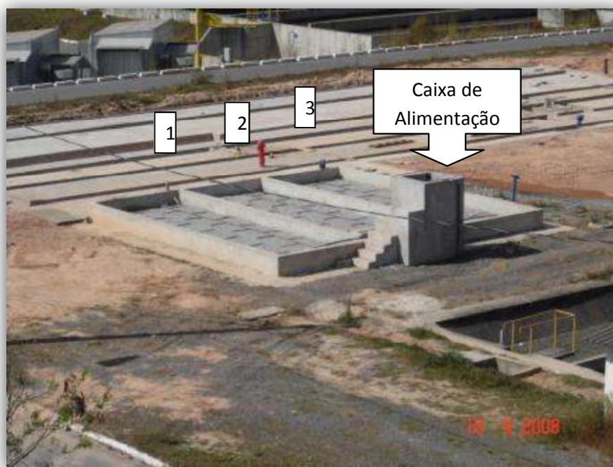
Figura 4.14 – Vista das unidades construídas, antes do plantio
