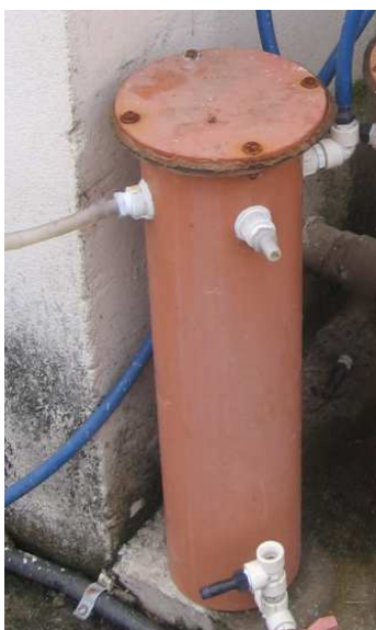
Figura 8.2 - Foto da caixa de dissipação (CD)
