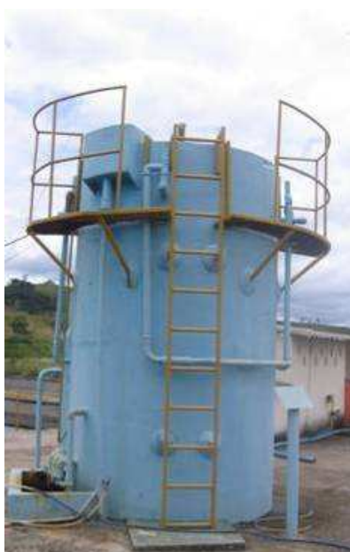
Figura 5.2 - Vista do reator UASB, escala demonstração (R demo )
