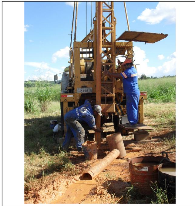
**FIGURA 7.24:** Sonda a percussão utilizada na perfuração dos poços de monitoramento.
