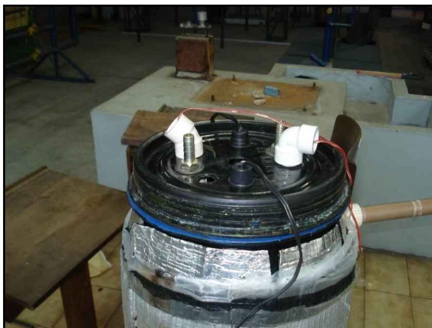
Figura 4.12 – Detalhe do sistema de aquecimento da água de aquecimento do reator anaeróbio
