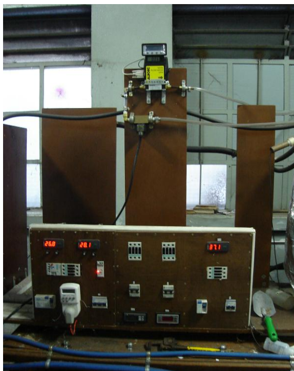
Figura 4.18 – Painel central de controle - detalhe
