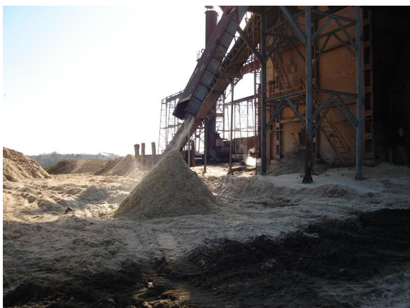
Figura 4.1 - Geração de bagaço de cana de de-açúcar na Usina - pilha de bagaço recém gerado (ao fundo, disposição de bagaço “antigo”)
