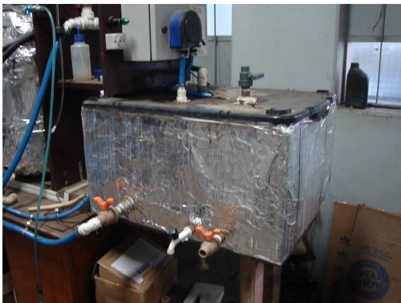
Figura 4.16 – Tanque de estocagem – detalhe
