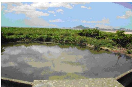
(a) lançamento de galeria de águas pluviais com contribuições de esgoto Jardim Camburi
