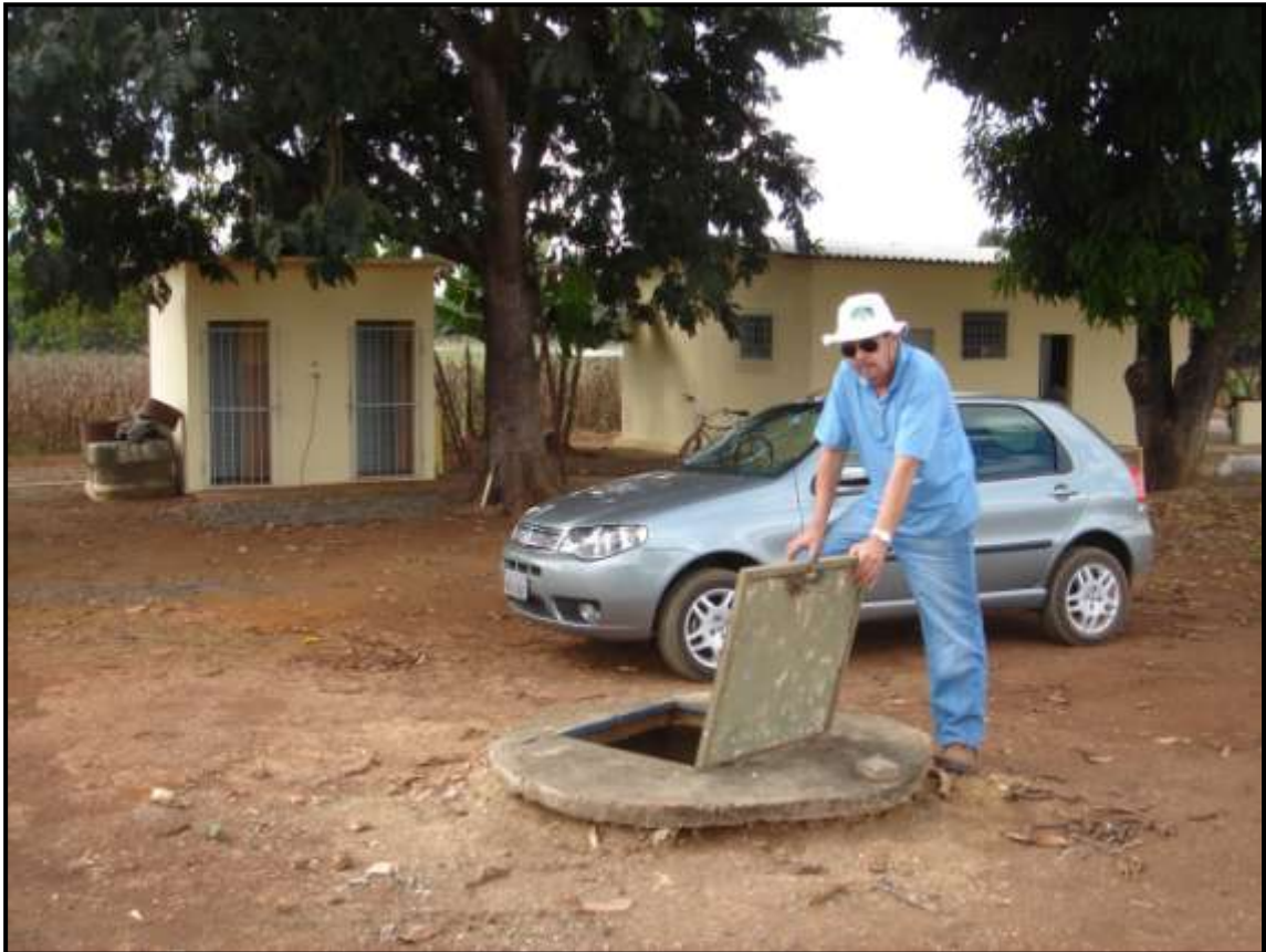
Figura F3 Cisterna do Barão (CIS-3) — Casa de apoio dos campos experimentais
