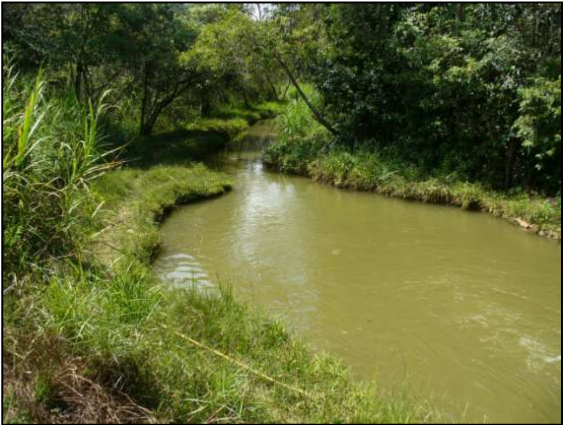
Figura F31 Alimentação do canal de irrigação, saída do vertedor da lagoa Baiana
