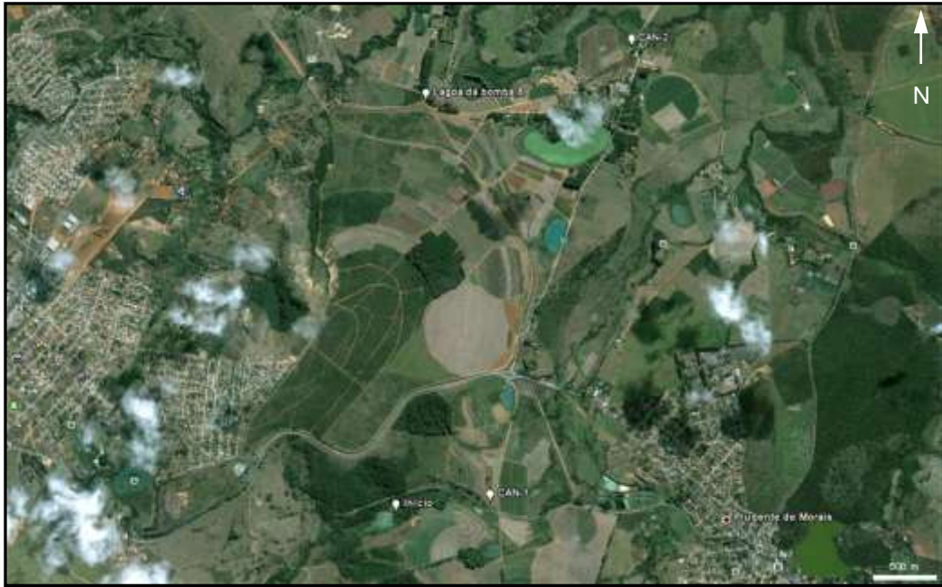
Figura 8.29 – Locais dos pontos de monitoramento no canal de irrigação
