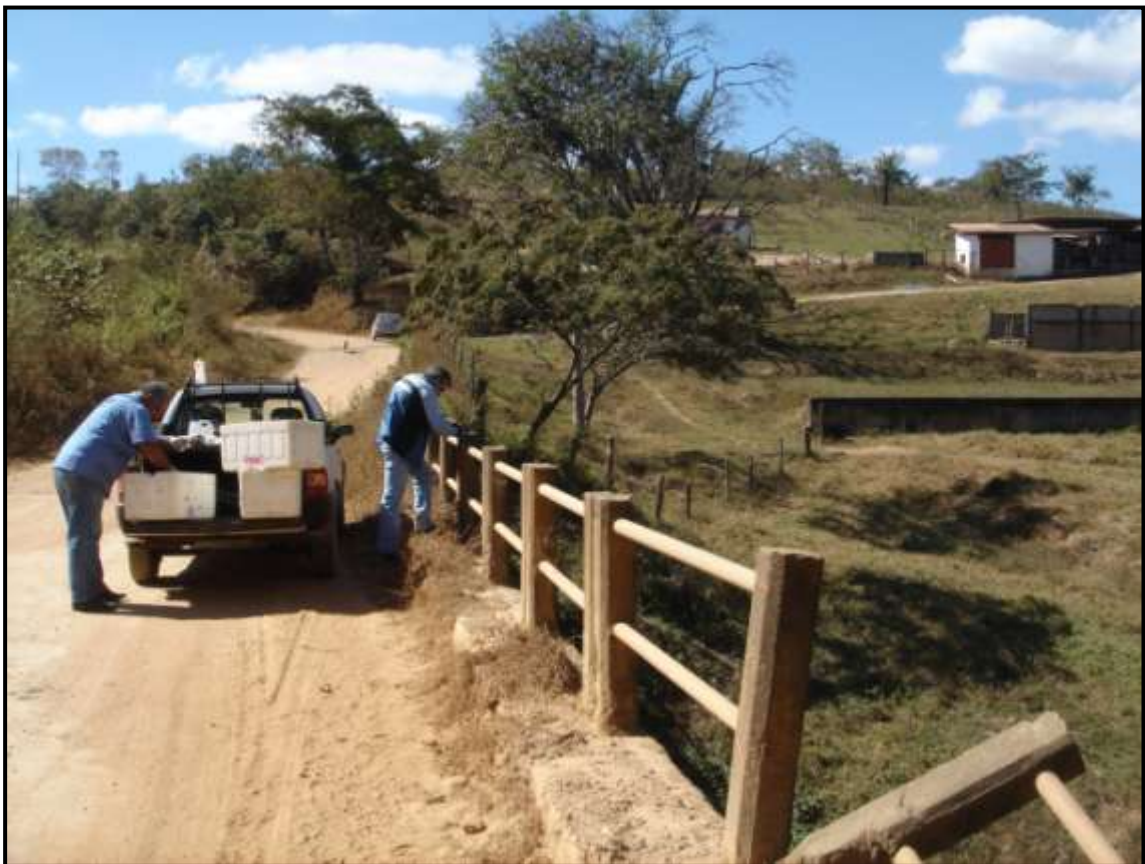
Figura F44 Rio Jequitibá, ponte na fazenda Monjolos, ponto JEQ-3
