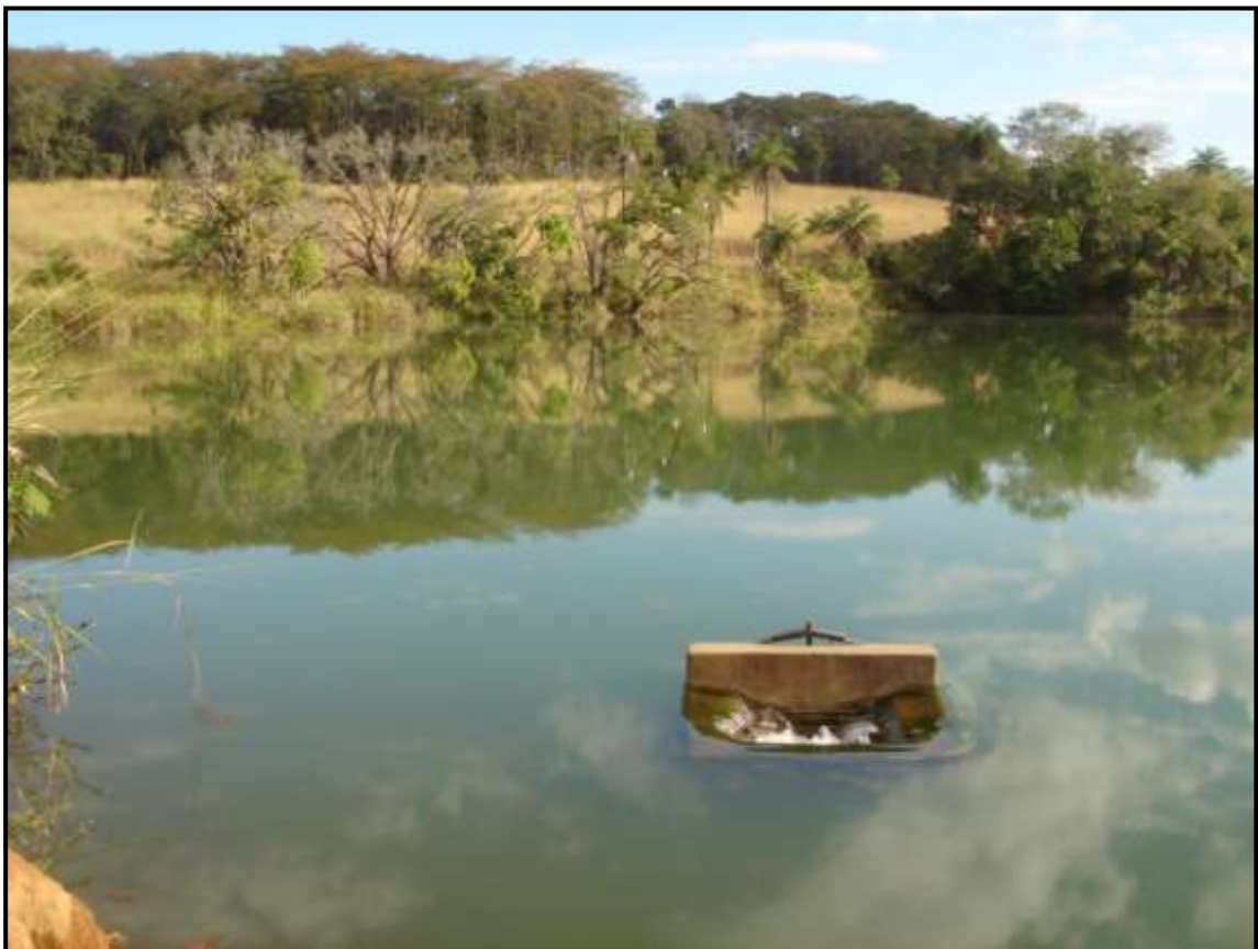
Figura F49 Vertedouro da lagoa da Baiana (ponto LAG-3)
