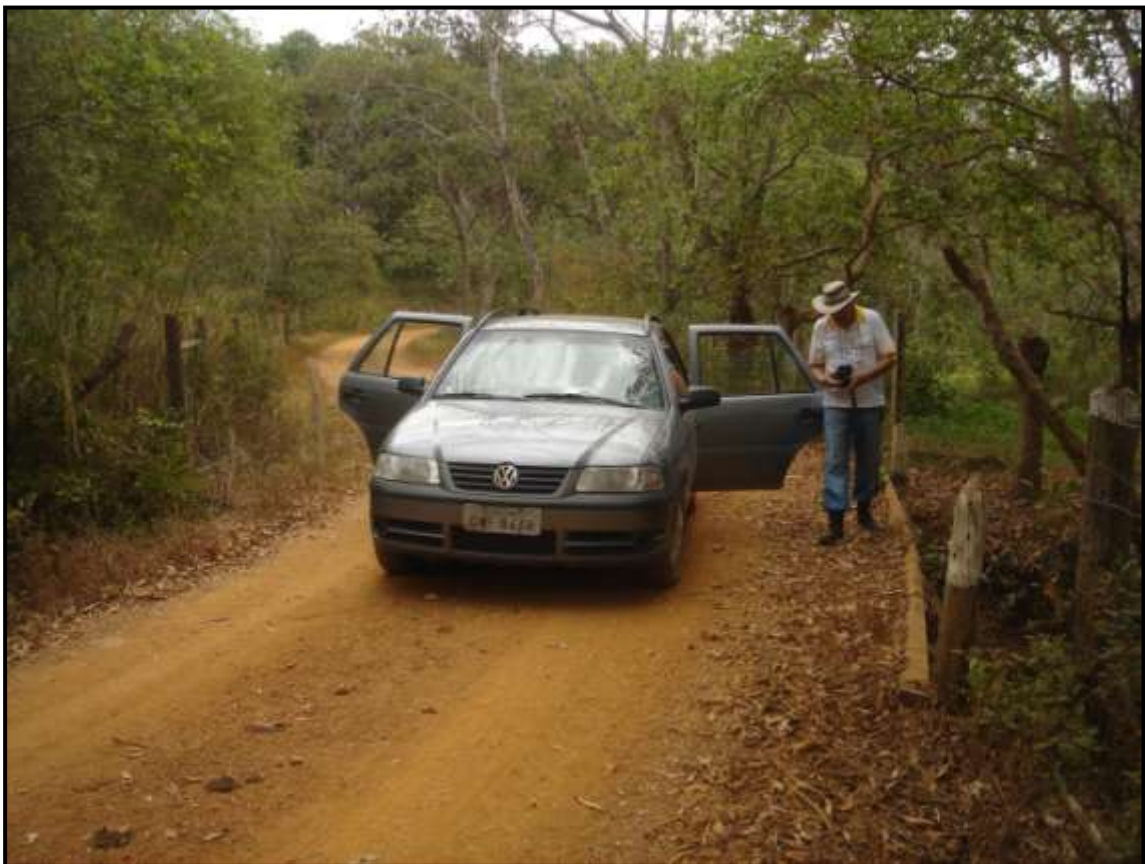
Figura F38 Ponte no córrego Forquilha, ponto FOR-1, área da sede da Epamig
