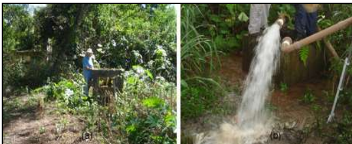
Figura 8.174 – Poço tubular jorrante da lagoa Subida da Estação
