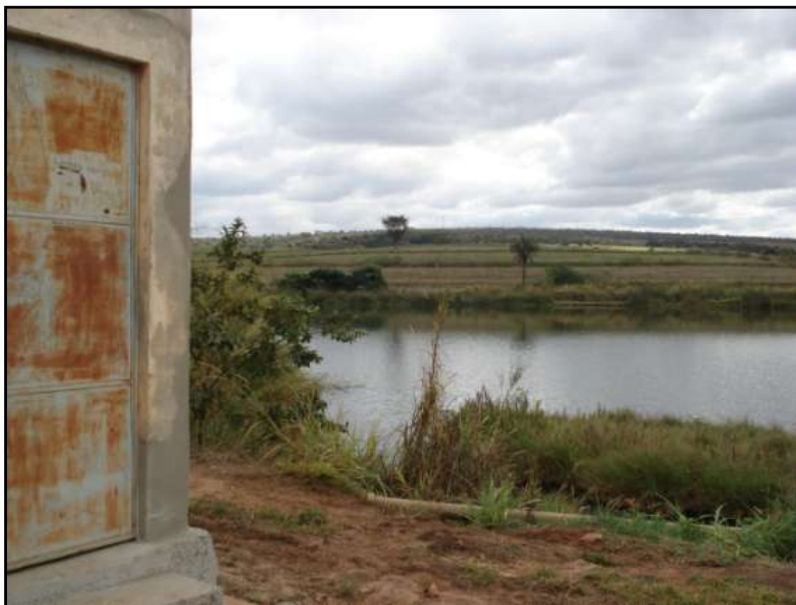
Figura F47 Casa de bomba da lagoa da Subida da Estação (ponto LAG-2)
