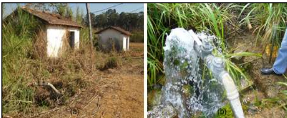
Figura 8.182 – Poço tubular jorrante da lagoa Olhos d'Água
