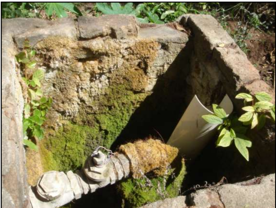
Figura F15 Poço tubular da lagoa Subida da Estação – Detalhe (PT-3)
