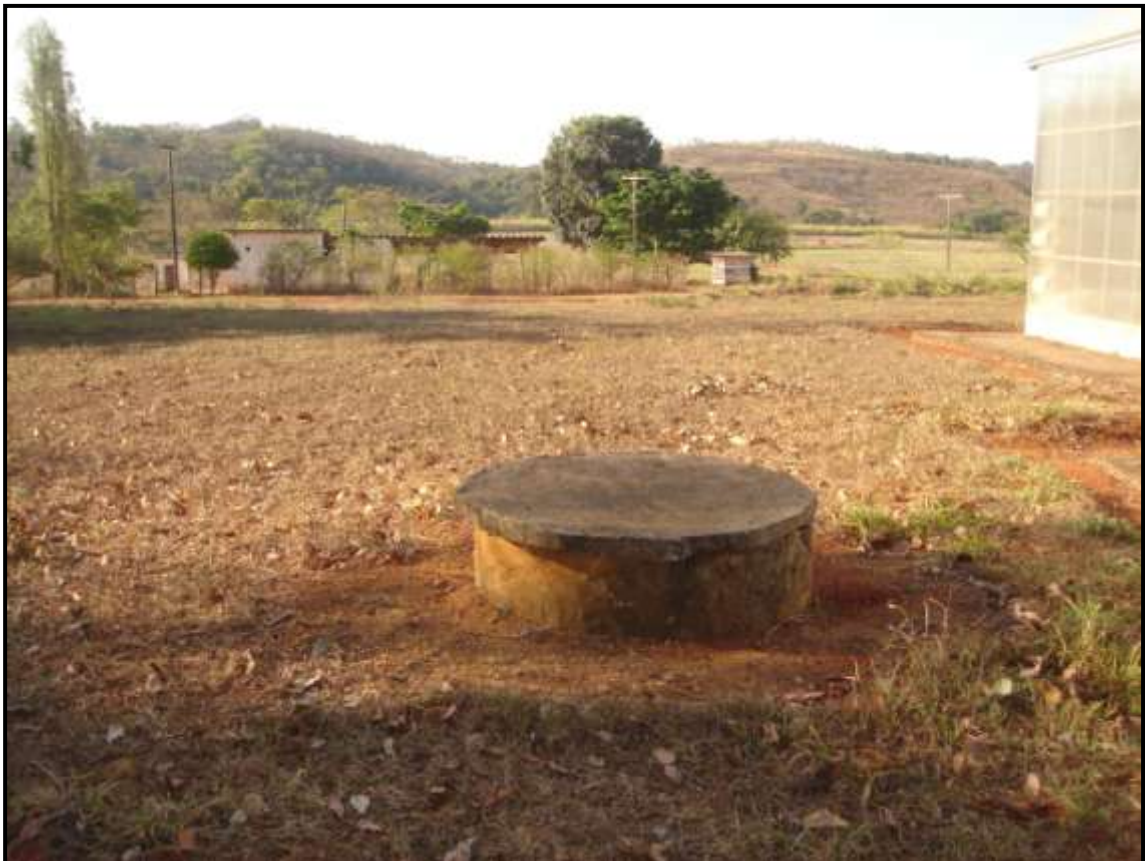
Figura F2 Cisterna da Estufa (CIS-2) – escritório dos campos experimentais
