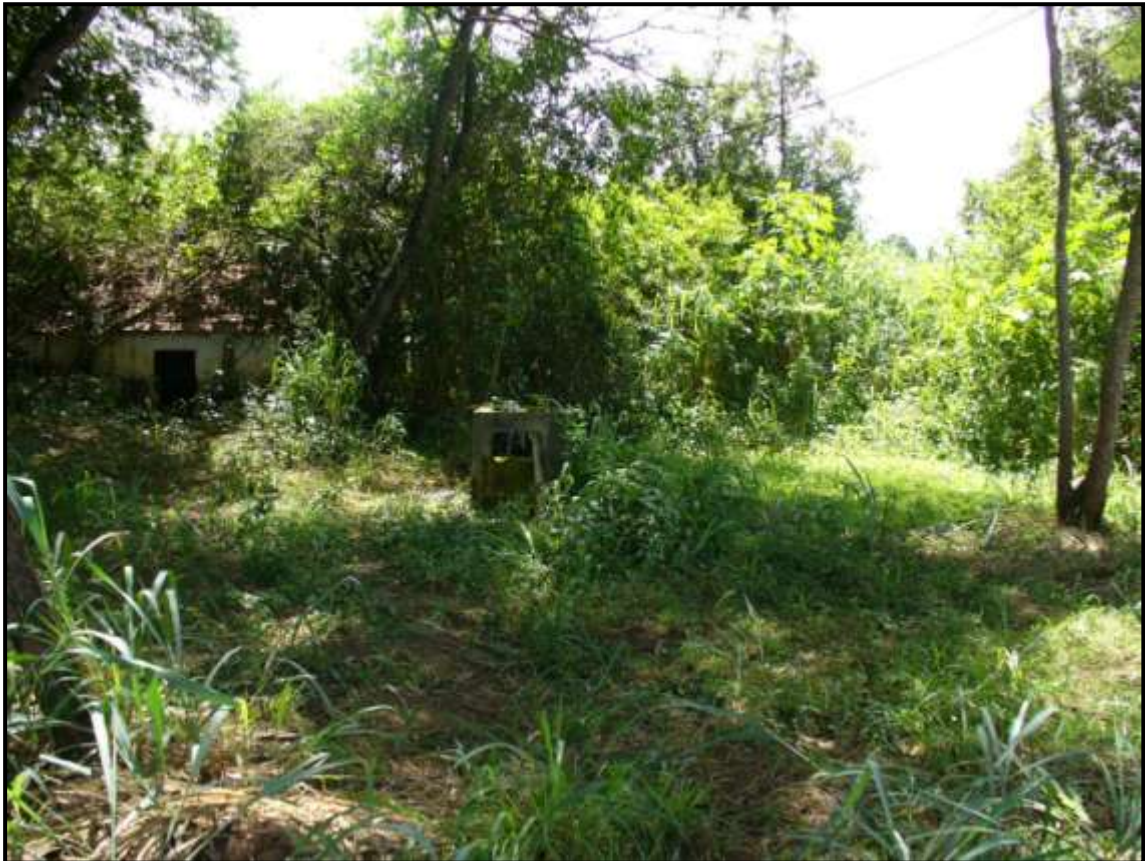
Figura F14 Poço tubular da lagoa Subida da Estação (ponto PT-3)
