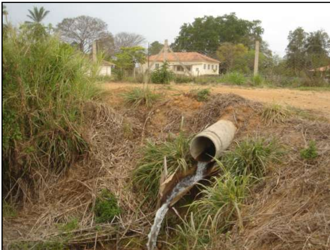
Figura F33 Canal de irrigação, CAN-2, trecho final
