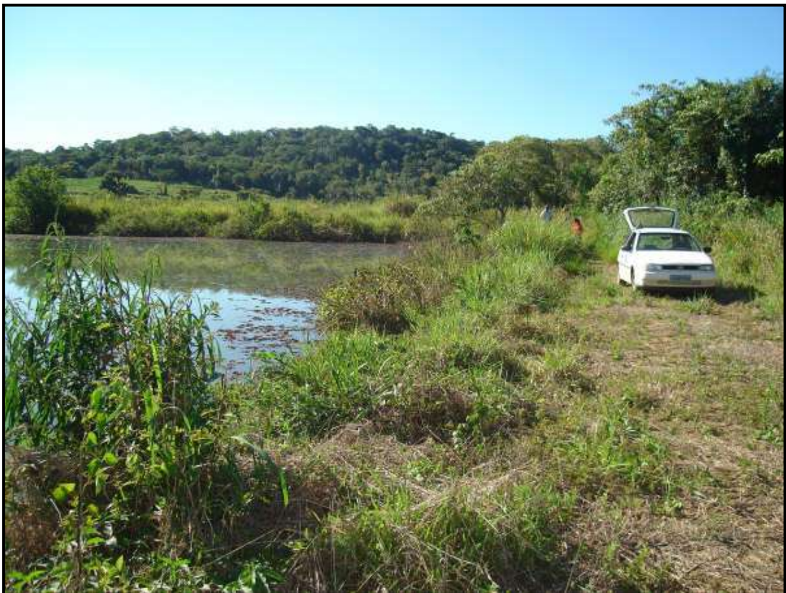
Figura F55 Vista da lagoa Poço Verde, local do vertedor
