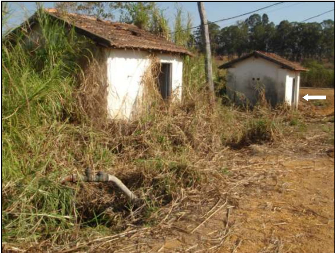
Figura F5 Local da cisterna da Associação – AEE (CIS-4)
