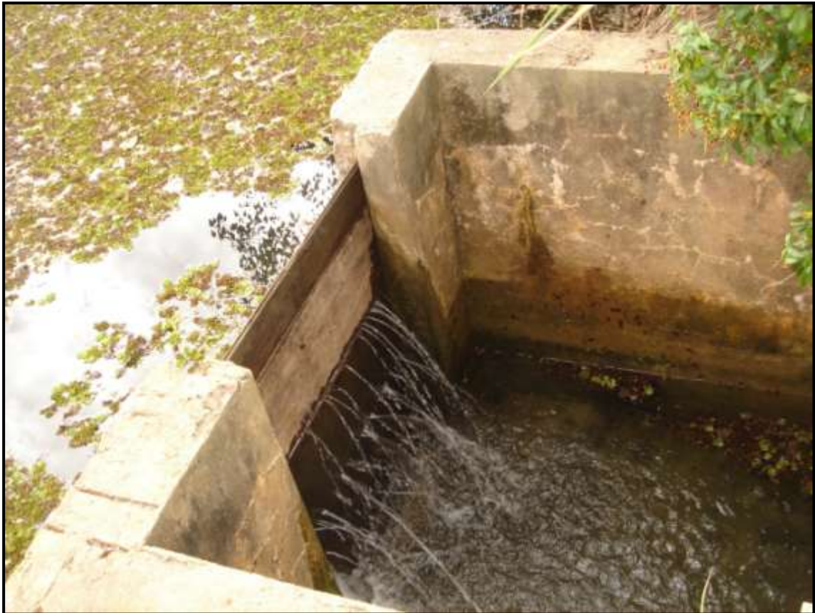
Figura 54 Vertedor da lagoa Poço Verde (ponto LAG-6)
