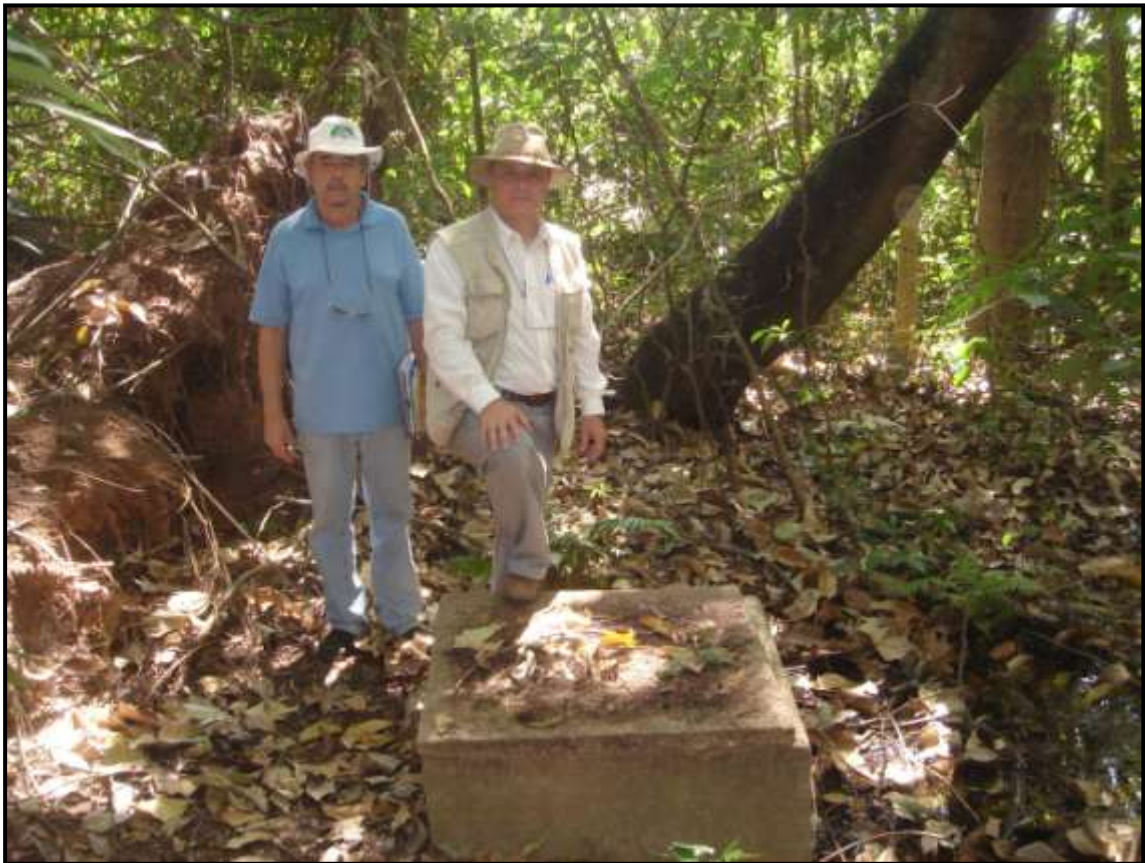
Figura F25 Caixa de coleta de água na surgência SURG-1
