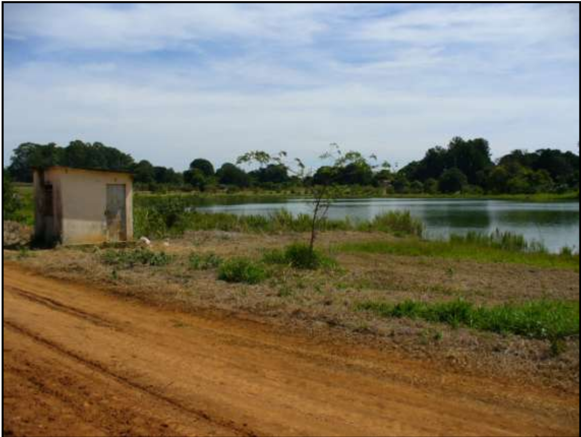
Figura F50 Casa da bomba da lagoa Capivara (ponto LAG-4)
