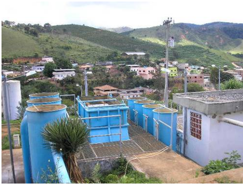
Figura 8.26 - Vista da ETA em Dom Corrêa.
