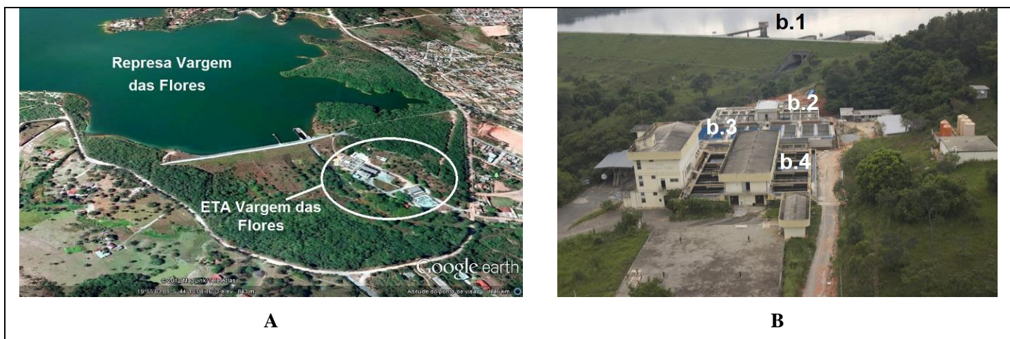
Figura 5.6 – Sistema Vargem das Flores: (A) vista geral, com posicionamento da Represa e da ETA Vargem das Flores; (B) detalhe da ETA Vargem das Flores: (b.1) captação, (b.2) floculadores, (b.3) flutuadores, (b.4) filtros.
