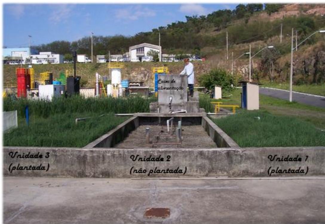
Figura 4.1: Sistema Alagado Construído de escoamento vertical composto por três unidades – CEPTs/UFMG-COPASA. Detalhe para a caixa de alimentação construída a montante do sistema
