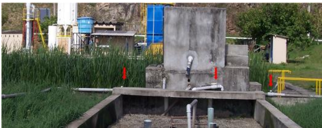
Figura 4.3: Indicação em vermelho da localização dos registros de controle do funcionamento das unidades
