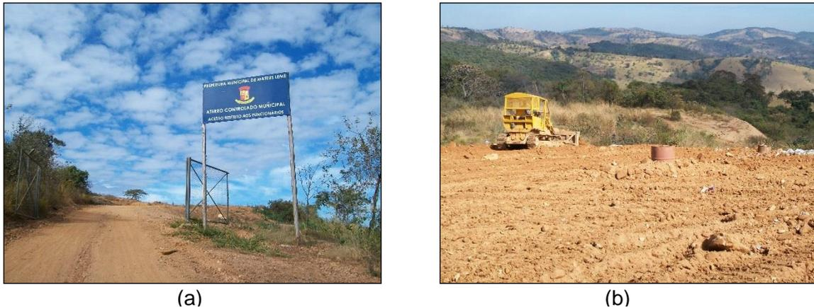
**Figura 7** - (a) Portão de acesso, placa de identificação e advertência. Localidade parcialmente fechada. (b) Observa-se drenos de gás e trator de esteira realizando a compactação e recobrimento dos resíduos. Os drenos não apresentam eficiência. Fonte: FEAM, 2010.
