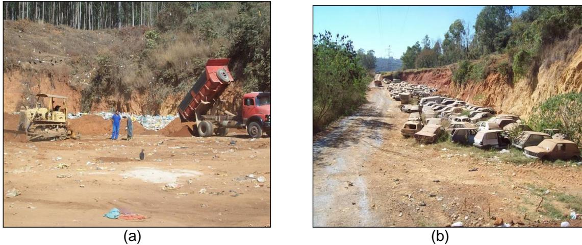
**Figura 10** - (a) Frente de operação realizando atividades de compactação e recobrimento. (b) Parte da área do aterro controlado utilizada pela Prefeitura como pátio de carros. Fonte: FEAM, 2010.
