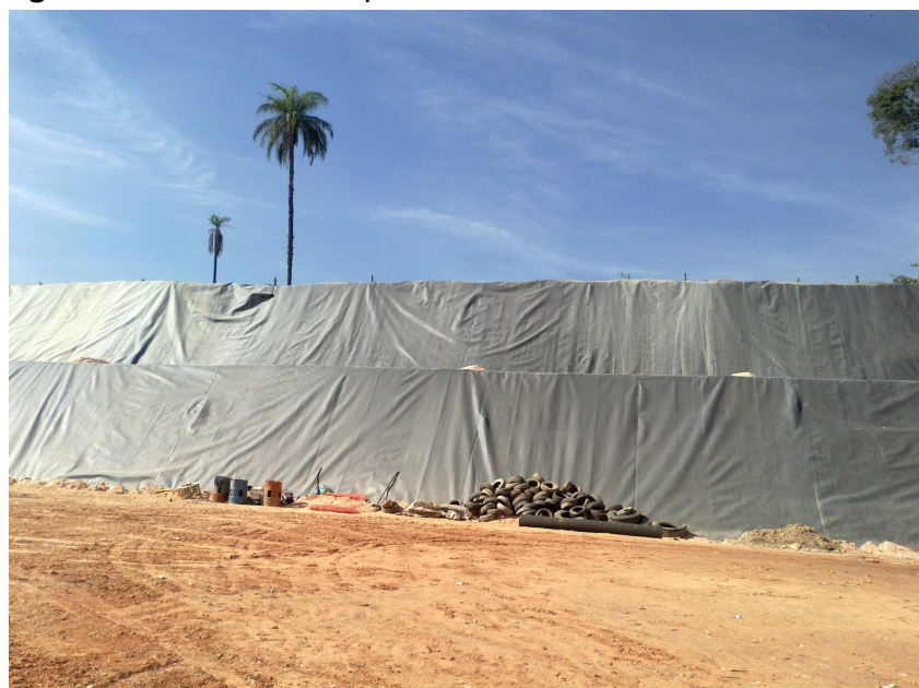
Figura 5.19 – Nova cava para aterramento de resíduos da CTRS Betim.
