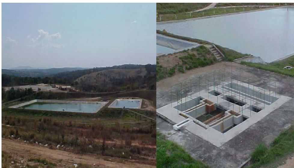
Figura 5.16 – Lagoas de Tratamento e Reator UASB da CTRS Betim.
