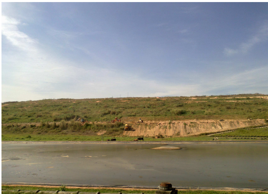
Figura 5.18 – Método de aterramento em rampa da CTRS Betim.
