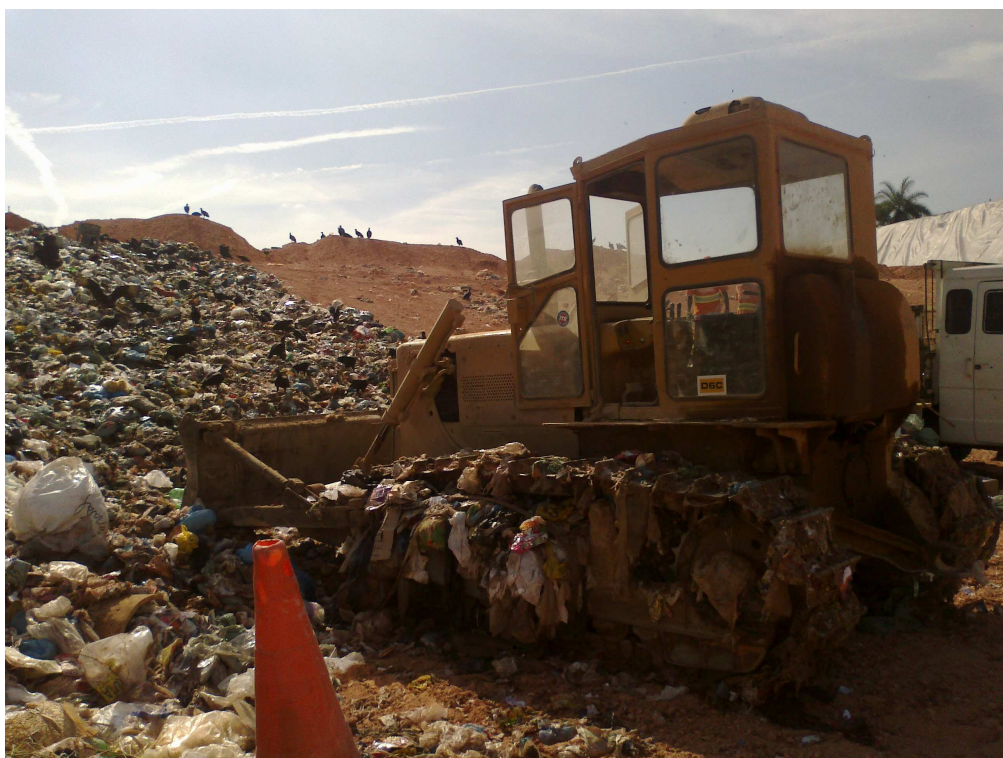
Figura 5.20 – Trator compactador executando o serviço de compactação dos resíduos na CTRS Betim
