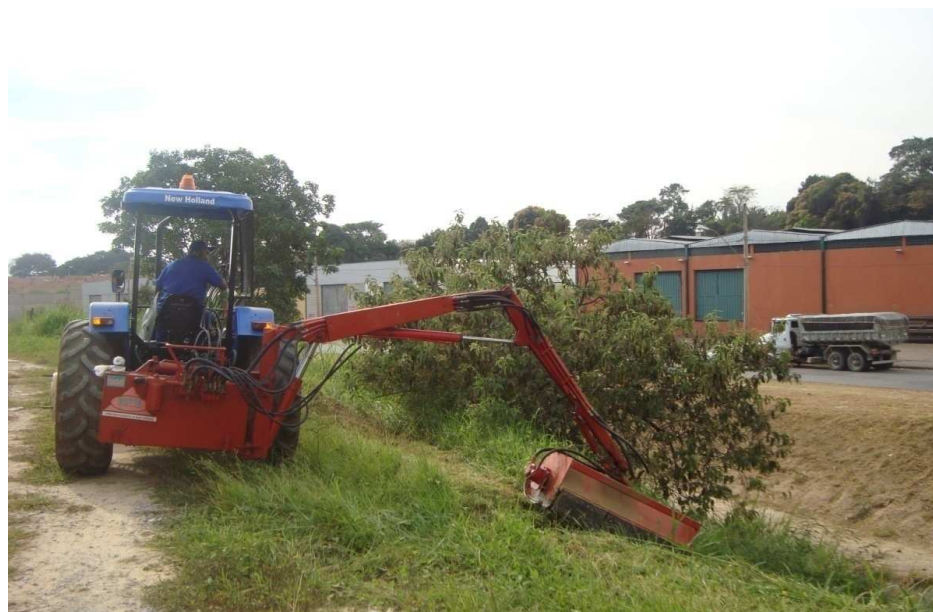
Figura 5.24 – Roçadeira mecanizada executando a limpeza de um córrego no município de Betim.
