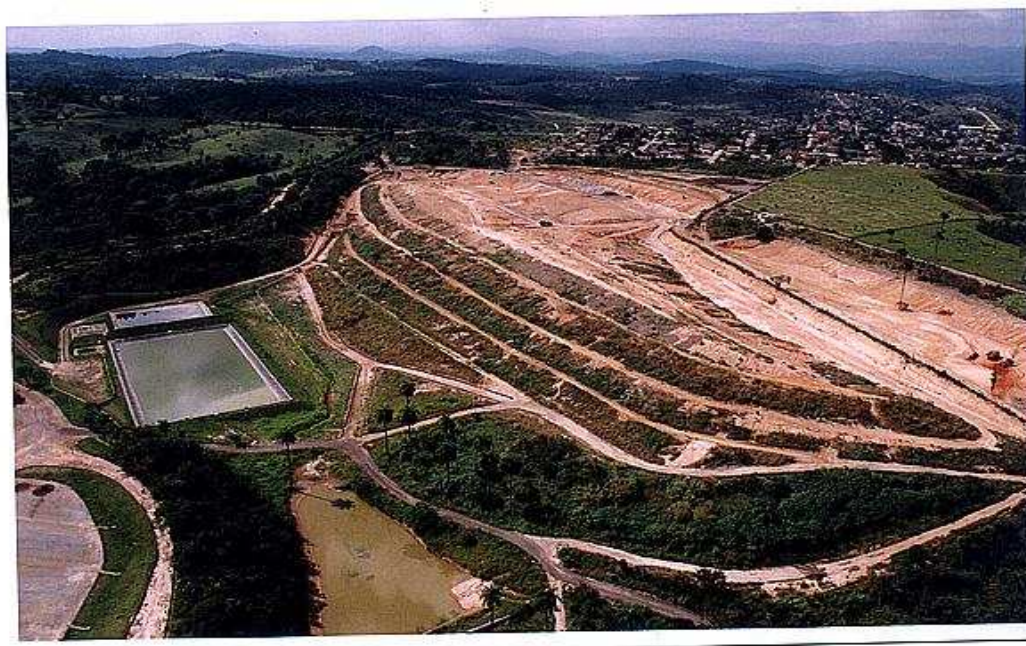
Figura 5.11 – Vista aérea do Aterro Sanitário de Betim.
