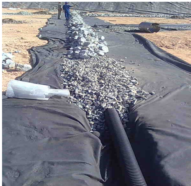
Figura 5.15 – Construção do Sistema de Drenagem da CTRS Betim.
