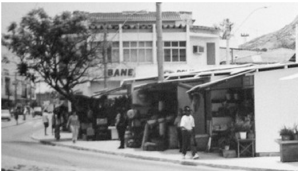
Figura 9 – Barracas construídas pela prefeitura em frente aos galpões destruídos Fonte: ACVR
