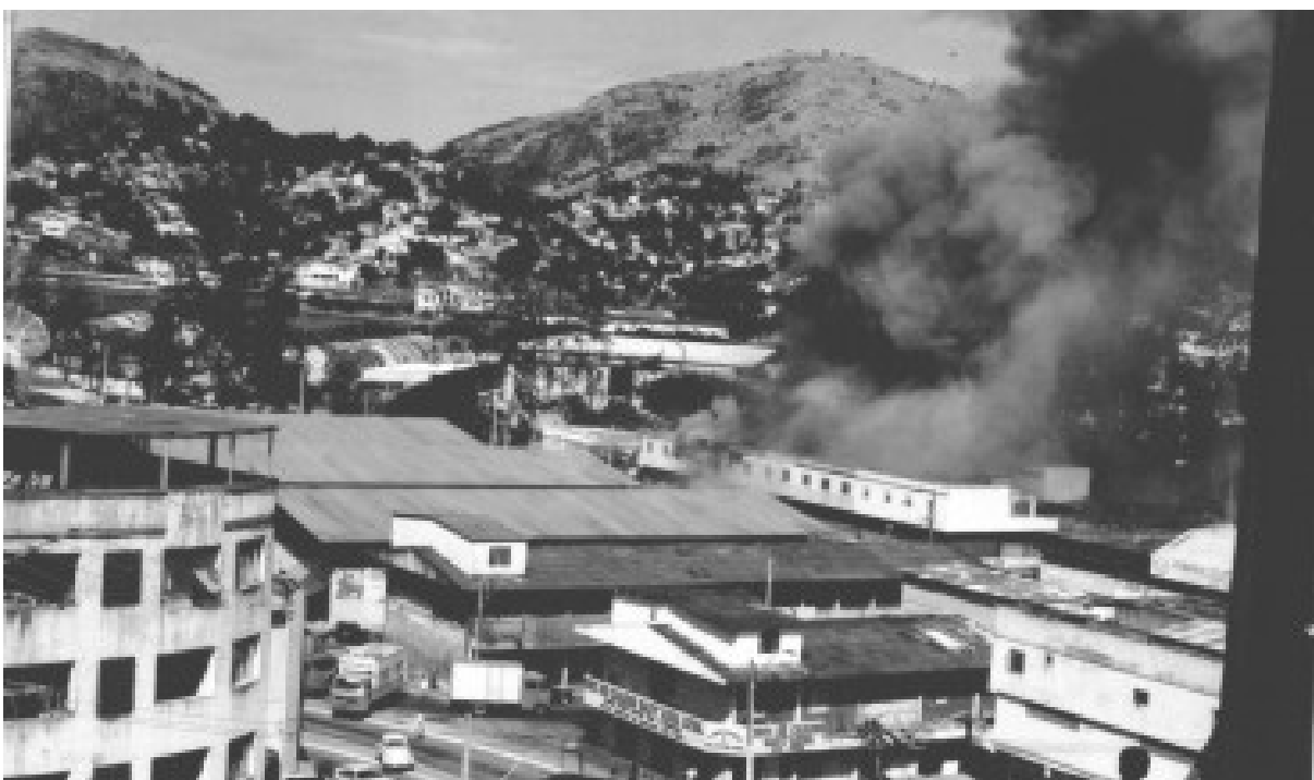
Figura 6 – Início do incêndio no Mercado da Vila Rubim Fonte: Comerciante Jair da Vitória
