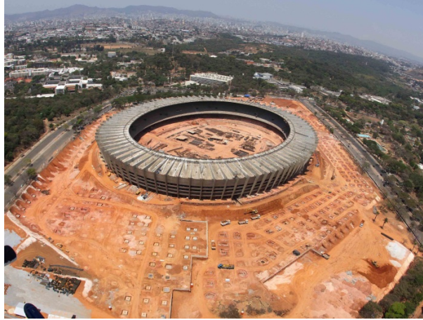
Figura 03 – Mineirão durante a reforma.
