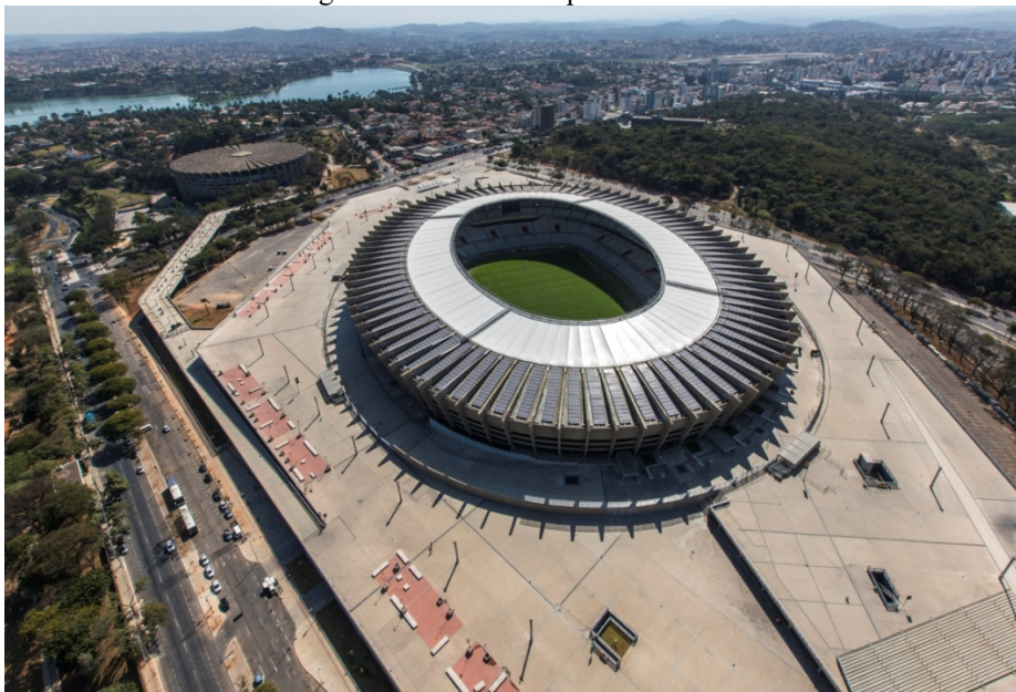
Figura 04 – Mineirão após a reforma.
