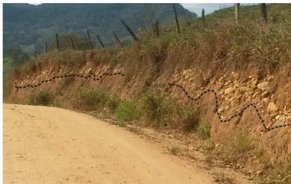
FIGURA 7.17 - Depósito do afluente do rio Paraopeba em posição de interflúvio com a extremidade acompanhando o caimento da vertente.
