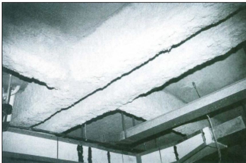
Figura 10 - Vigas de aço revestidas com argamassa de vermiculita, por meio de “spray”.
