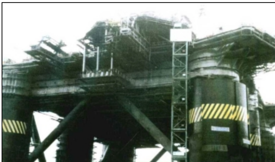
Figura 11 - Aplicação de argamassa de vermiculita na plataforma P-19 da Petrobras. Também para os pilares mistos o concreto resiste juntamente com o aço às solicitações atuantes na estrutura para temperatura ambiente e em situação de incêndio.
