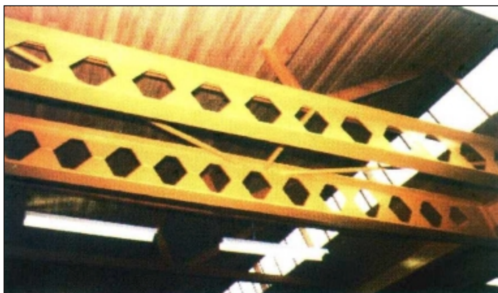
Figura 7 - Estrutura metálica protegida com tinta intumescente.
