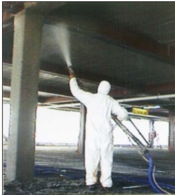
Figura 4 - Aplicação de uma argamassa à base de cimento e fibras minerais.
