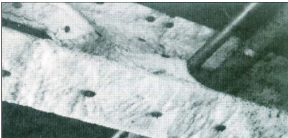
Figura 8 - Viga metálica protegida com manta cerâmica.
