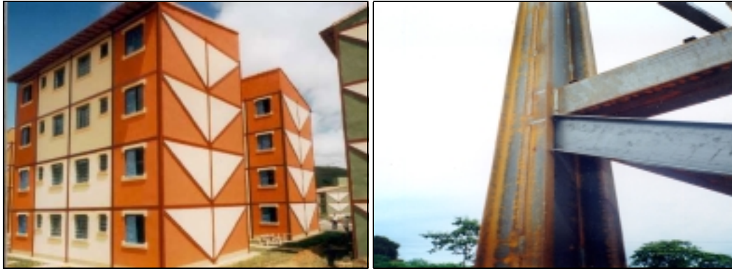
Figura 1.3 - Estrutura dos edifícios COHAB [31] e Usiteto [32], de 4 pavimentos.
