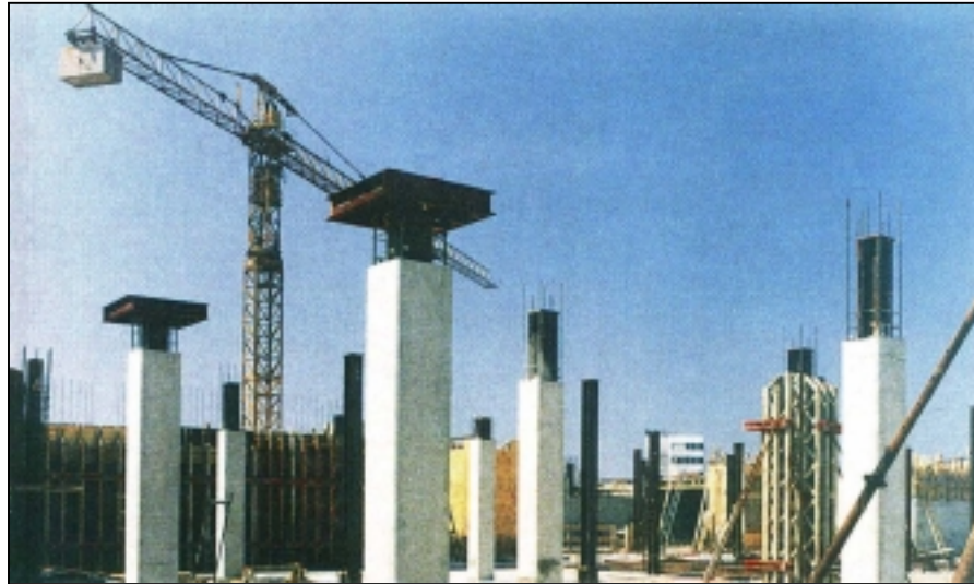
Figura 12 - Pilares mistos de aço totalmente revestidos de concreto.
