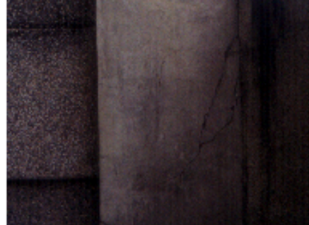
FOTO 20 TRINCA EM PILAR
