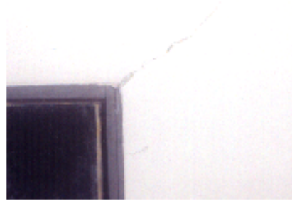
FOTO 18 TRINCA NA LAJE
