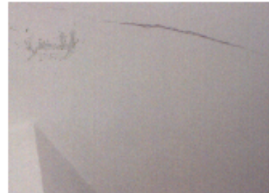
FOTO 20 TRINCA EM PILAR
