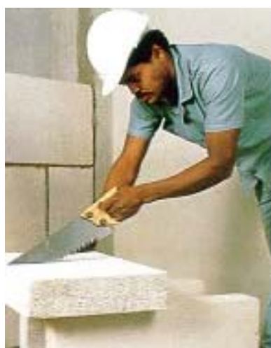
FIGURA 2.3 – Corte de bloco de concreto celular autoclavado com o uso de um serrote (catálogo SICAL)
